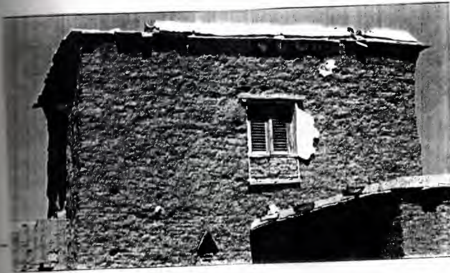
Fotoğraf No : 35 Hanayın (ebeveyin yatak odası) Güney yönünden, ön avludan görünüşü.
