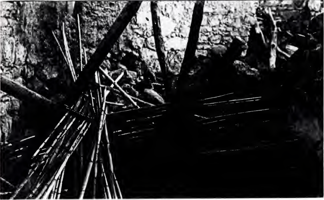
Fotograf No: 150 Ahırın yıkılan tavan taşıyıcıları ve tavan örtüsünün görünüşü
