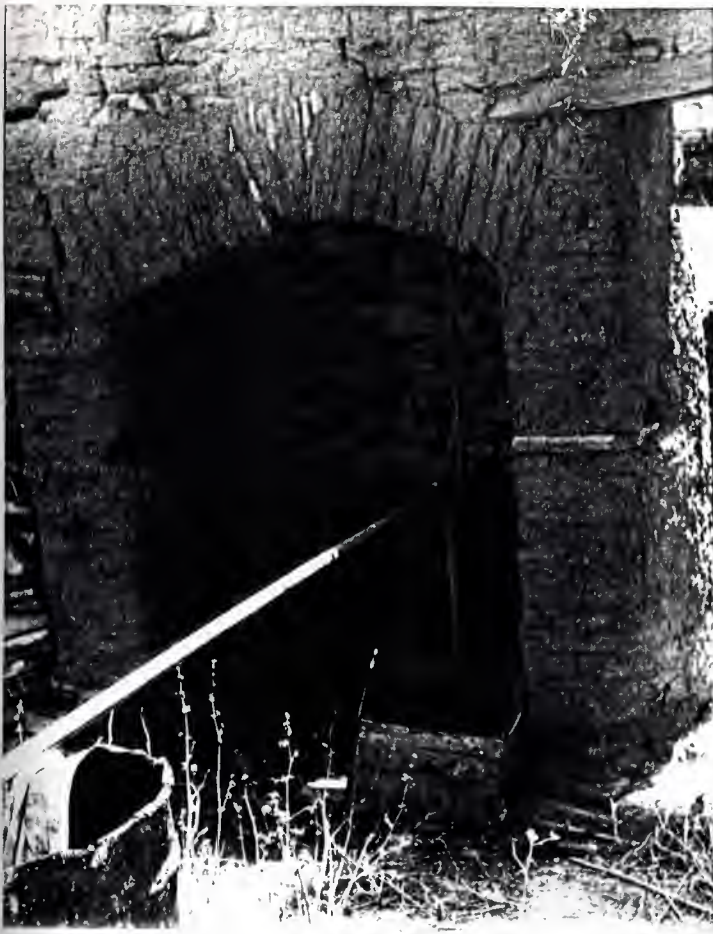
Fotograf No: 115 Zahire odası duvarı üzerinde bulunan kuyunun görünüşü.
