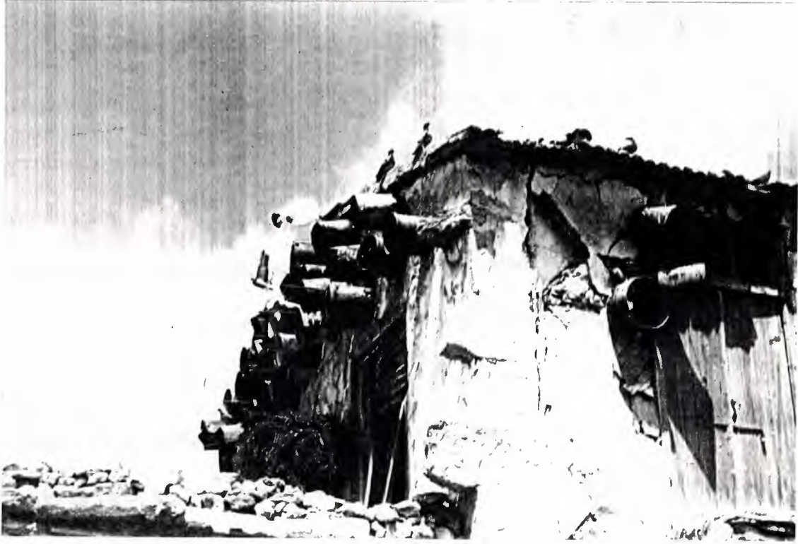
Fotograf No: 166 Hanayın köşe detayı görünüşü
