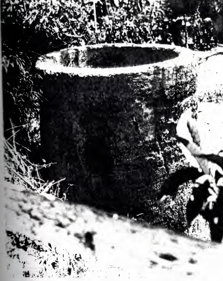
Fotoğraf No: 43 Su deposunun görünüşü.
