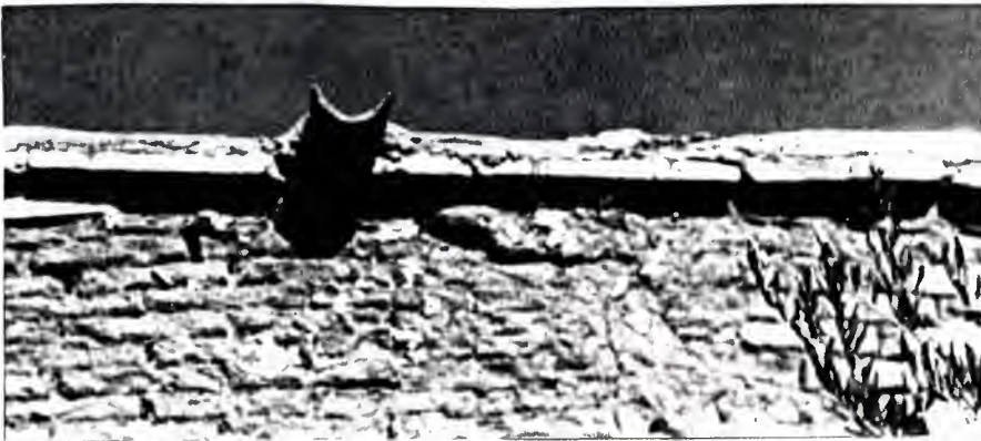
Fotograf No: 136 Binanın damında bulunan bir çörtenin görünüşü
