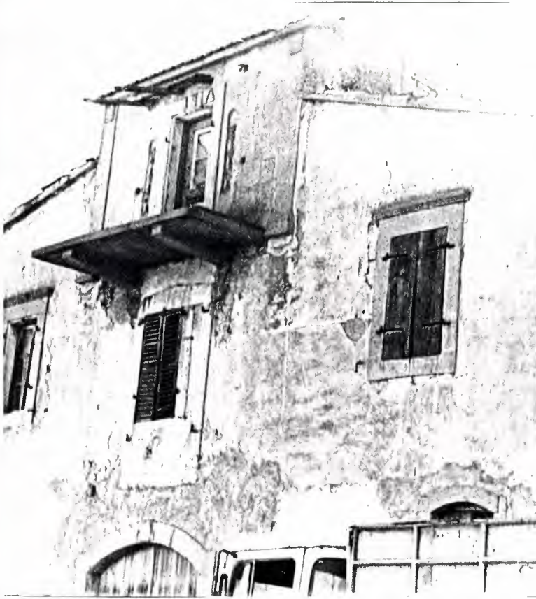
Fotograf No: 103 Kuzey-Doğu yönünden, yol cepesinden konutun görünüşü
