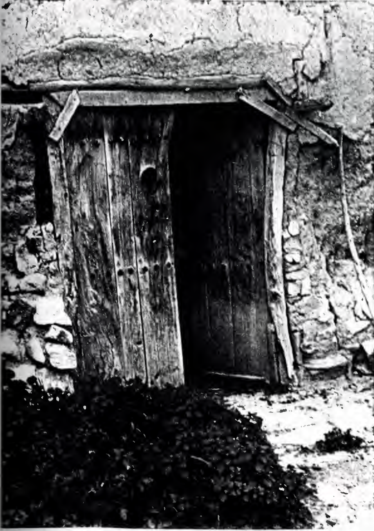
Fotoğraf No: 55 Yaşam odası kapısının Doğu yönünden, avludan görünüşü.
