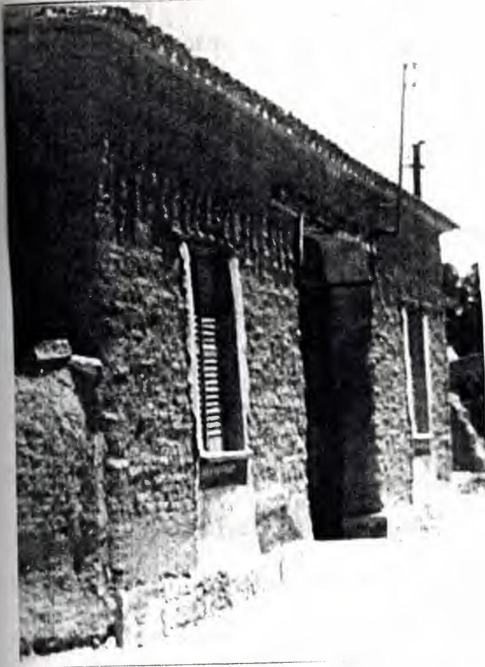
Fotoğraf No: 97 Binanın Kuzey-Batı yönünden, yol cephesinden görünüşü
