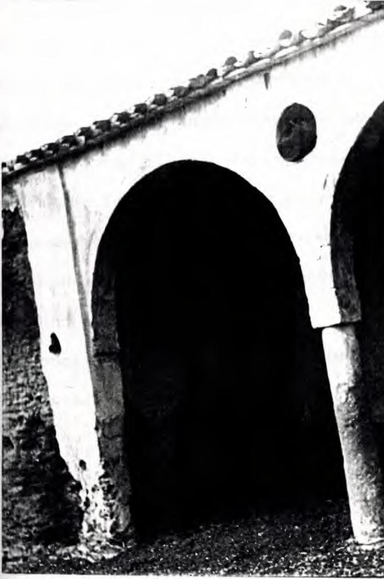
Fotoğraf No: 17 Balkon kemerlerinin Güney yönünden görünüşü.
