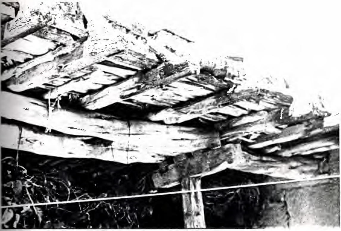
Fotoğraf No: 46 Balkon tavan taşıyıcıları ve saçak kenarları görünüşü
