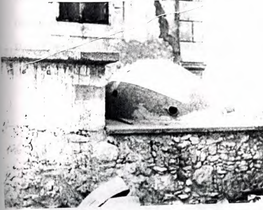
Fotoğraf No:102 Hamam kubbesinin Güney yönünden görünüşü
