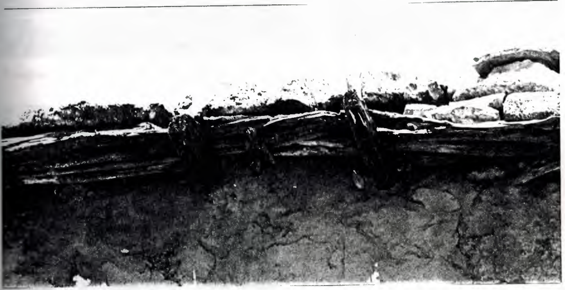
Fotoğraf No: 45 Konut damının saçaklarının görünüşü.
