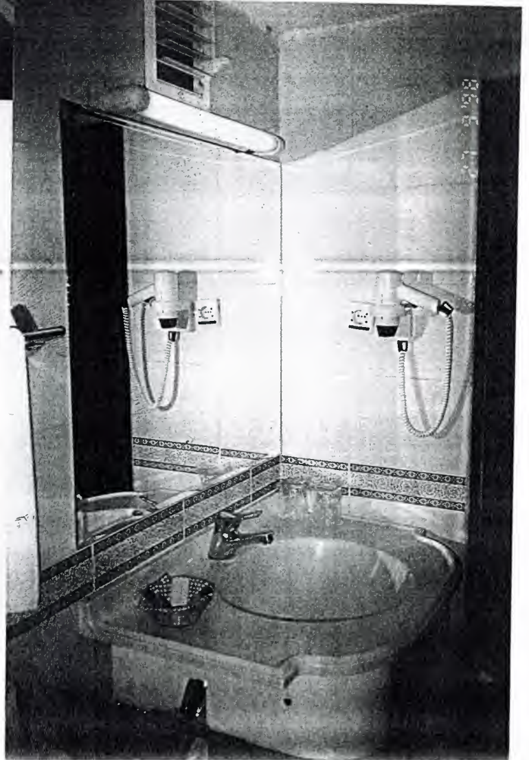
Şekil 140: Kuşadası Öküz Mehmet Paşa Kervansarayı Yatak Odaları Islak Hacimlerinden Bir Görünüş Kaynak: Hicran Özalp Özel Arşivi
