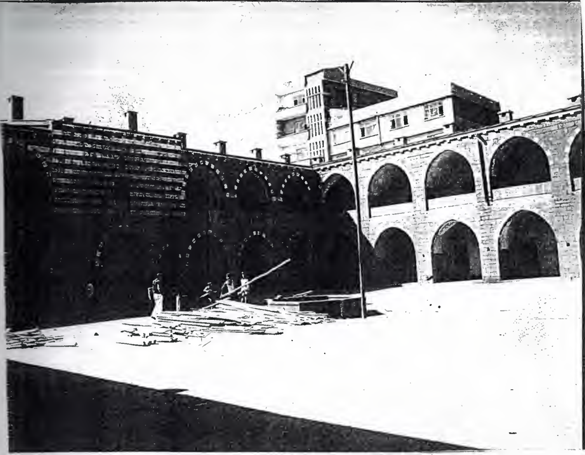
Şekil 196: Diyarbakır Deliller Hanı Restorasyon Çalışmaları Kaynak: Vakıflar Genel Müdürlüğü Arşivi
