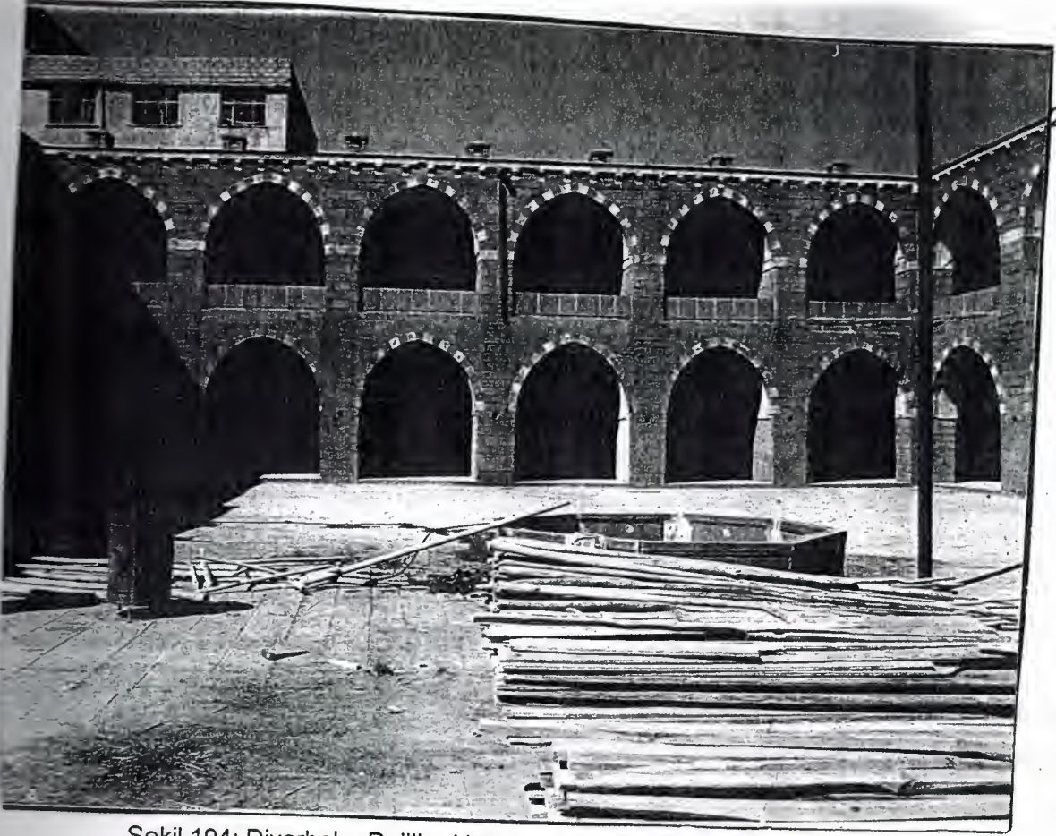
Şekil 194: Diyarbakır Deliller Hanı Restorasyon Çalışmaları Kaynak: Vakıflar Genel Müdürlüğü Arşivi
