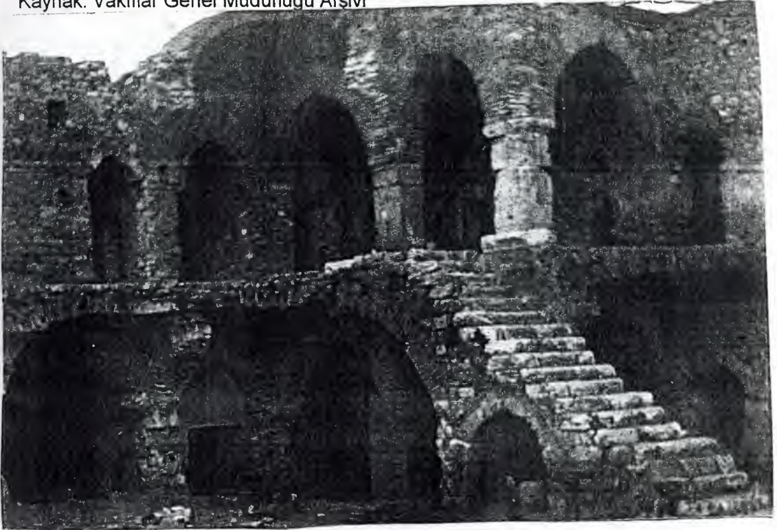
Şekil 100: Kuşadası Öküz Mehmet Paşa Kervansarayı Kaynak: Vakıflar Genel Müdürlüğü Arşivi
