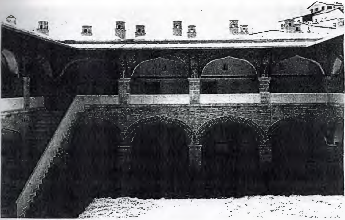
Şekil 97: Kuşadası Öküz Mehmet Paşa Kervansarayı Kaynak: Vakıflar Genel Müdürlüğü Arşivi
