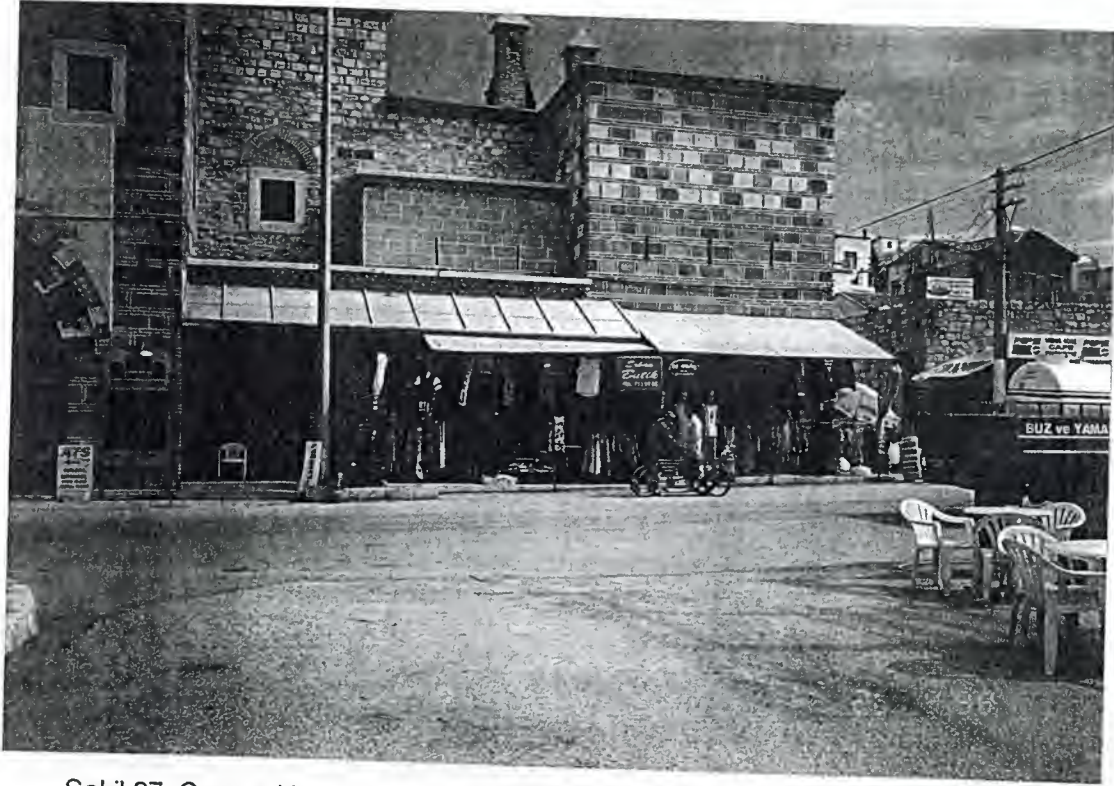
Şekil 27: Çeşme Kanuni Kervansarayı Ön Cephe, Ticarethanelerin Görünüşü Kaynak: Hicran Özalp Özel Arşivi
