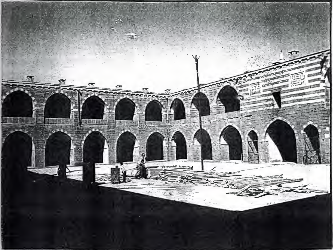
Şekil 197: Diyarbakır Deliller Hanı Restorasyon Çalışmaları Kaynak: Vakıflar Genel Müdürlüğü Arşivi
