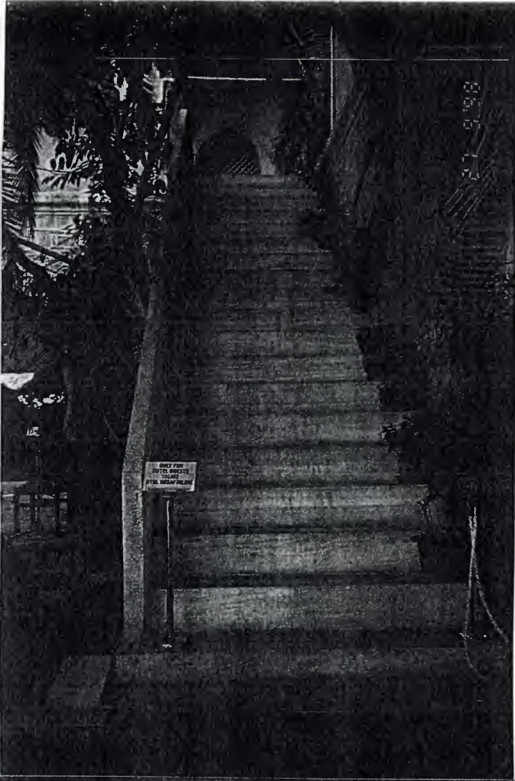
Şekil 127: Kuşadası Öküz Mehmet Paşa Kervansarayı İkinci Kat Çıkış Merdiveni Kaynak: Hicran Özalp Özel Arşivi
