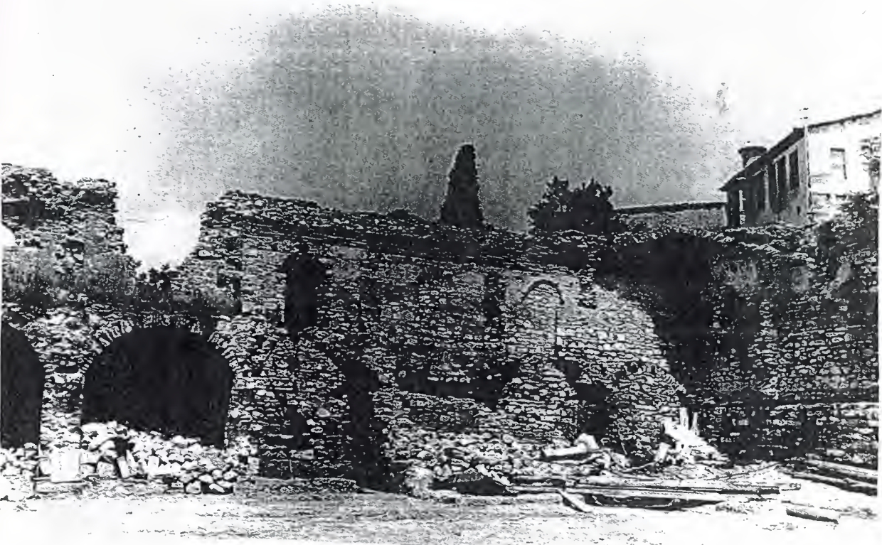
Şekil 14: Çeşme Kanuni Kervansarayı Restorasyon Öncesi Durumu Kaynak: Vakıflar Genel Müdürlüğü Arşivi
