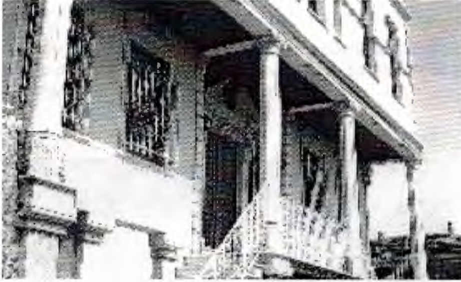
(Şekil 8) Halilpaşa Konağı
