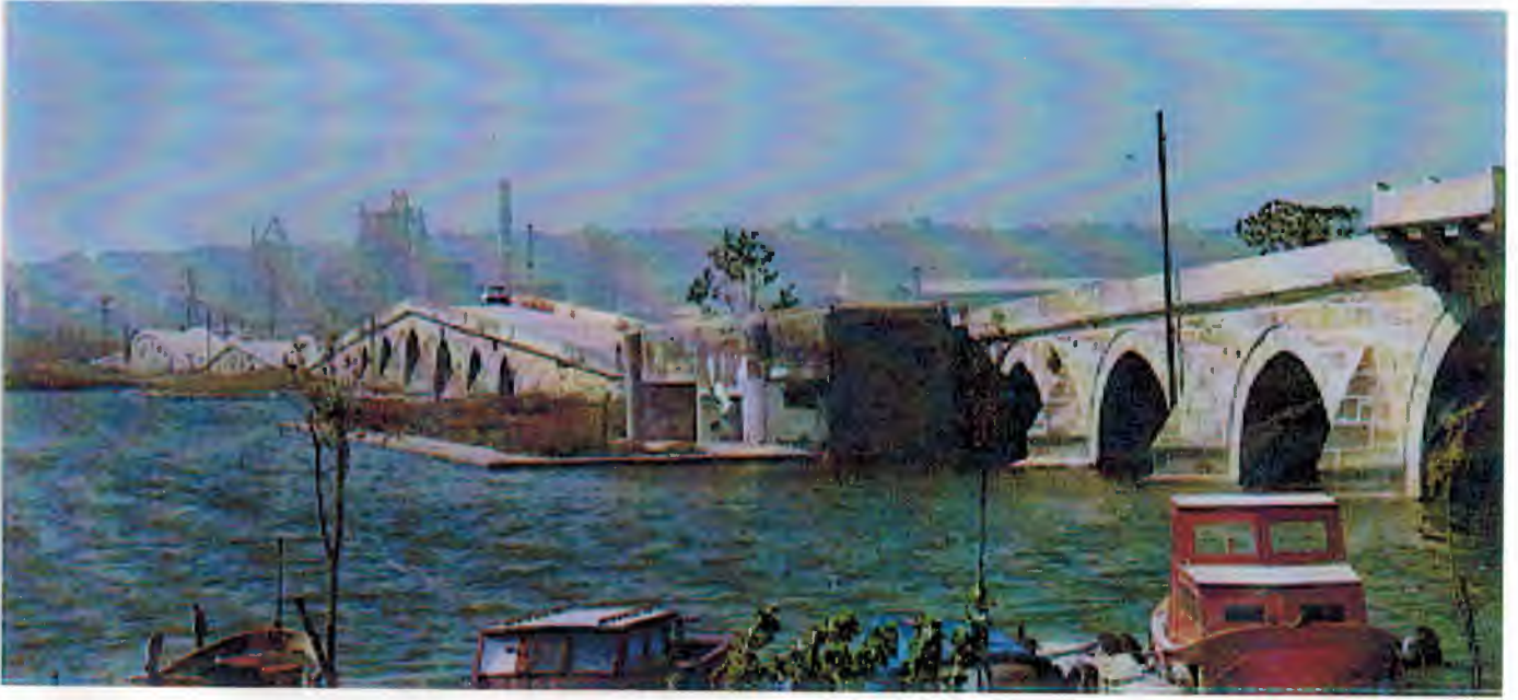
BÜYÜKÇEKMECE MİMAR SİNAN KÖPRÜSÜ
