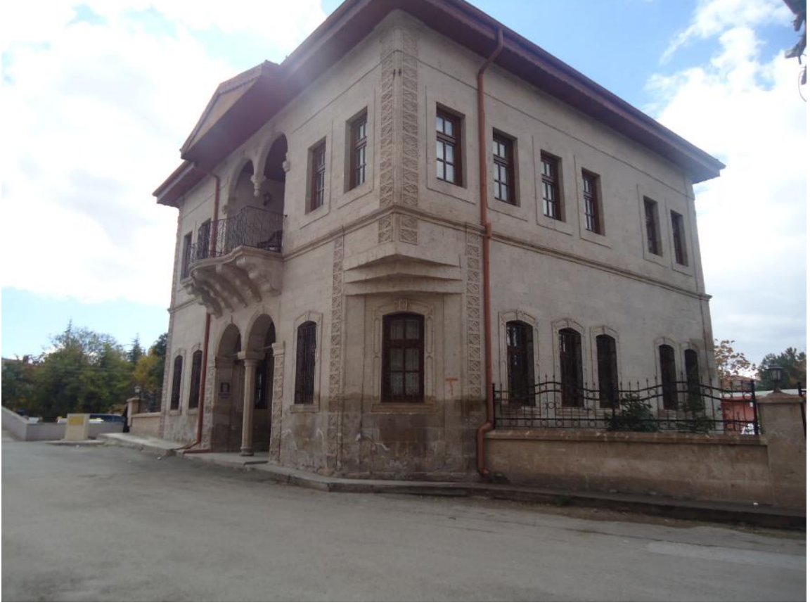
Şekil 5. 72 İbrahim Kaya Konağı'nın kuzeybatı cephesi (Bediha Uğur).
