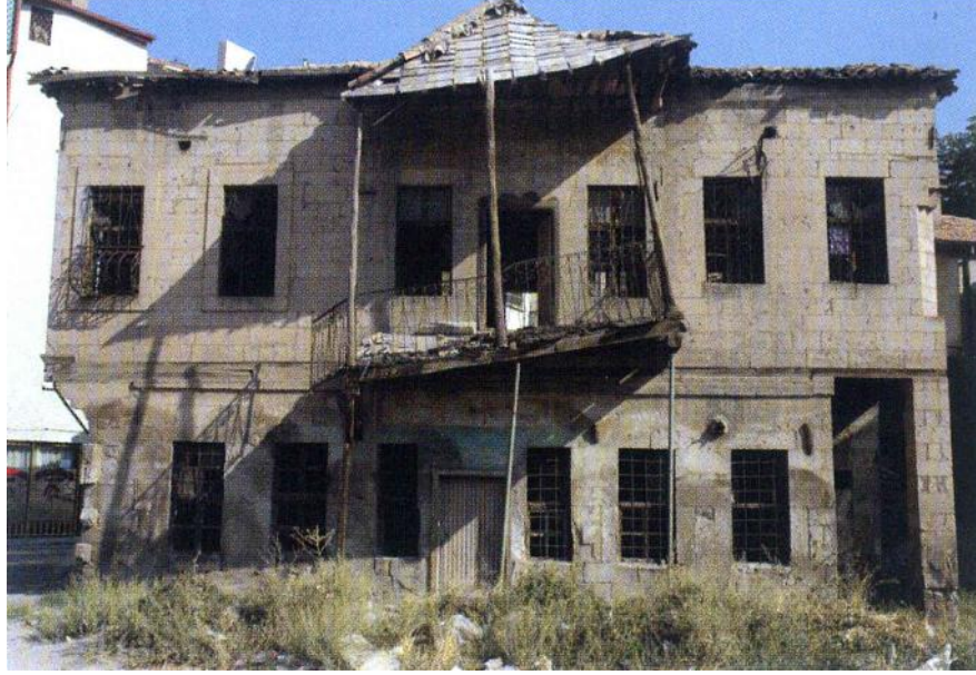
Şekil 5. 84 Aksaray İli'nin Merkez İlçesi'nin Zincirli Mahallesi'nde bulunan Mehmet Turgut Konağı'nın onarım görmeden önceki hali (Erdem, R. , ve diğerleri, 2004).
