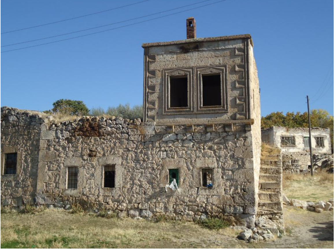
Şekil 5. 61 Aksaray İli'nin Ağzıkarahan Köyü'nde bulunan taş oyma işçiliği ile yapılmış konut (Bediha Uğur).
