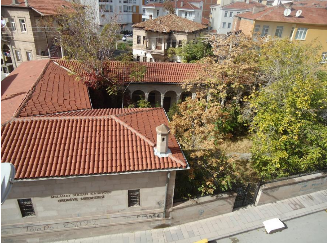
Şekil 5. 40 Aksaray İli'nin Merkez İlçesi'nin Taşpazar Mahallesi'nde bulunan Kadioğlu (Bedriye) Medresesi (Bediha Uğur).
