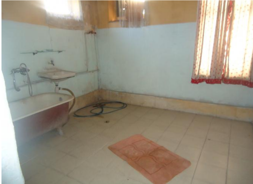
Şekil 5. 138 Çorakçılar Konağı'nın birinci katında bulunan tuvalet ve banyonun zemini (Bediha Uğur).
