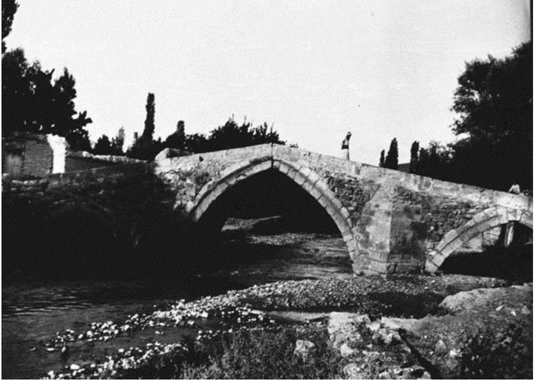
Şekil 5. 12 Aksaray İli'nin Merkez İlçesi'nin Nakkaş Caddesi'nde bulunan Nakkaş Köprüsü'nün onarım görmeden önceki hali ( http://www.aceqli68.com/eski-aksaray-resimleri2-t3955.0.html ) (22. 05. 2013). (Şehir Merkezi Haritası'nda numara: 3 Nakkaş Köprüsü).
