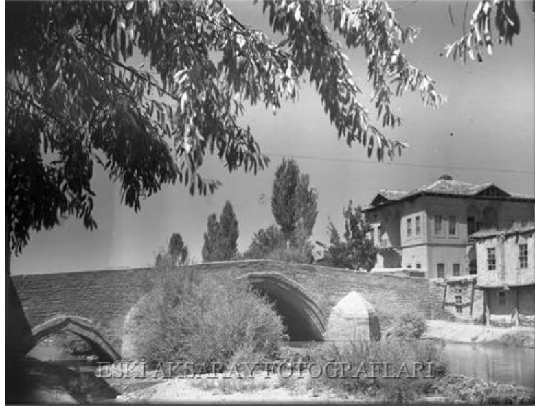
Şekil 5. 6 Aksaray İli'nin Merkez İlçesi'nin Zinciriye Mahallesi'nde bulunan Baş Köprü'nün onarım görmeden önceki hali ( http://www.muzafteray.name.tr/eskiaksaray/pages/eskiaksaray%20(47).jpg.htm ) (21. 05. 2013). (Şehir Merkezi Haritası'nda numara: 1 Bölcek Köprüsü).
