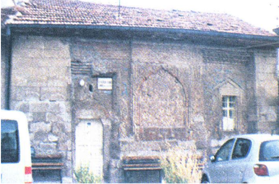
Şekil 5. 14 Aksaray İli'nin Merkez İlçesi'nin Muhsin Çelebi Mahallesi'nde bulunan Cıncıklı Mescit'in onarım görmeden önceki hali (Kaya, E. , 2009) . (Şehir Merkezi Haritası'nda numara: 4 Cıncıklı Mescit).
