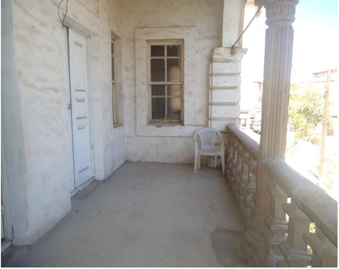
Şekil 5. 109 Çorakçılar Konağı'nın birinci katında bulunan ve eyvandan ulaşılan balkon (Bediha Uğur).
