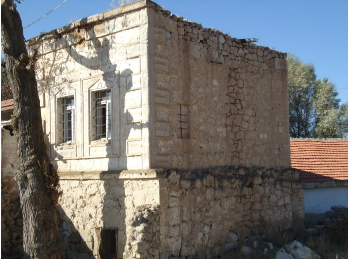
Şekil 6. 6 Aksaray İli'nin Ağzıkarahan Köyü'nde bulunan taş oyma işçiliği ile yapılmış konut (Bediha Uğur).
