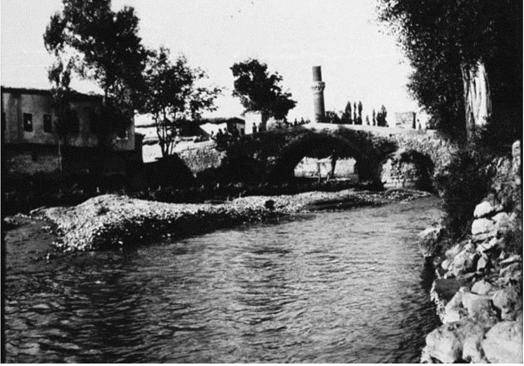
Şekil 5. 8 Aksaray İli'nin Merkez İlçesi'nin Hasas Caddesi'nde bulunan Bedbağlar (Hasas) Köprüsü'nün onarım görmeden önceki hali ( http://www.acemli68.com/eski-aksaray-resimleri2-t3955.0.html ) (21. 05. 2013). (Şehir Merkezi Haritası'nda numara: 2 Hasas Köprüsü).
