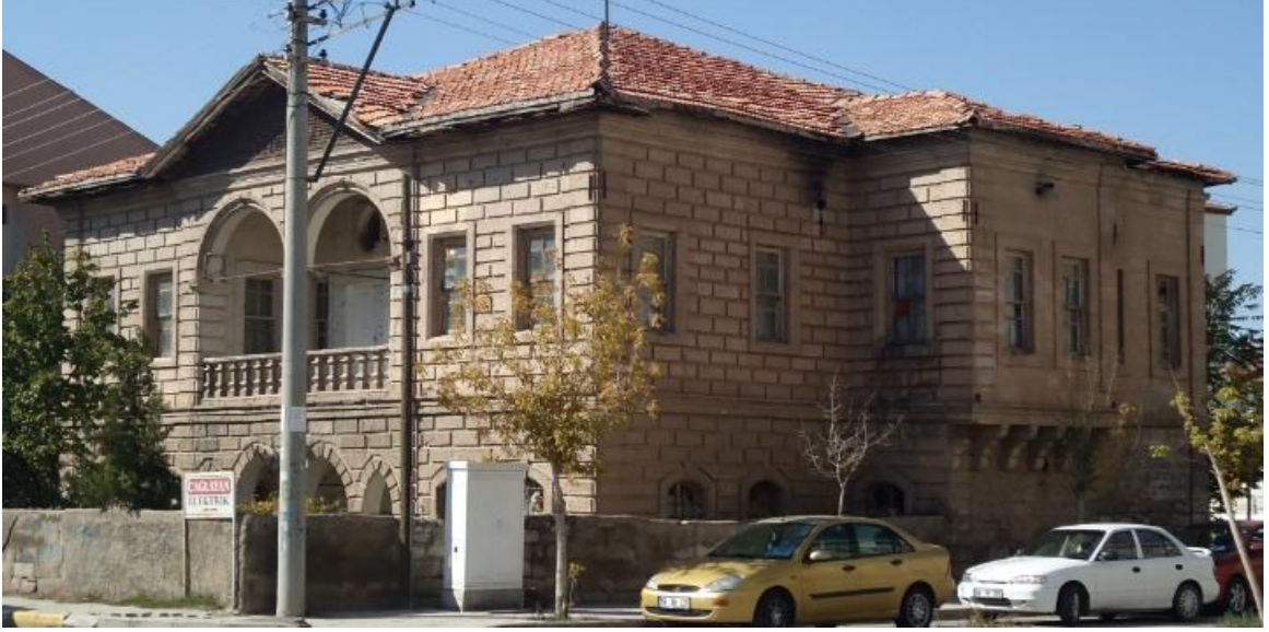
Şekil 5. 131 Çorakçılar Konağı'nın çatısı (Bediha Uğur).
