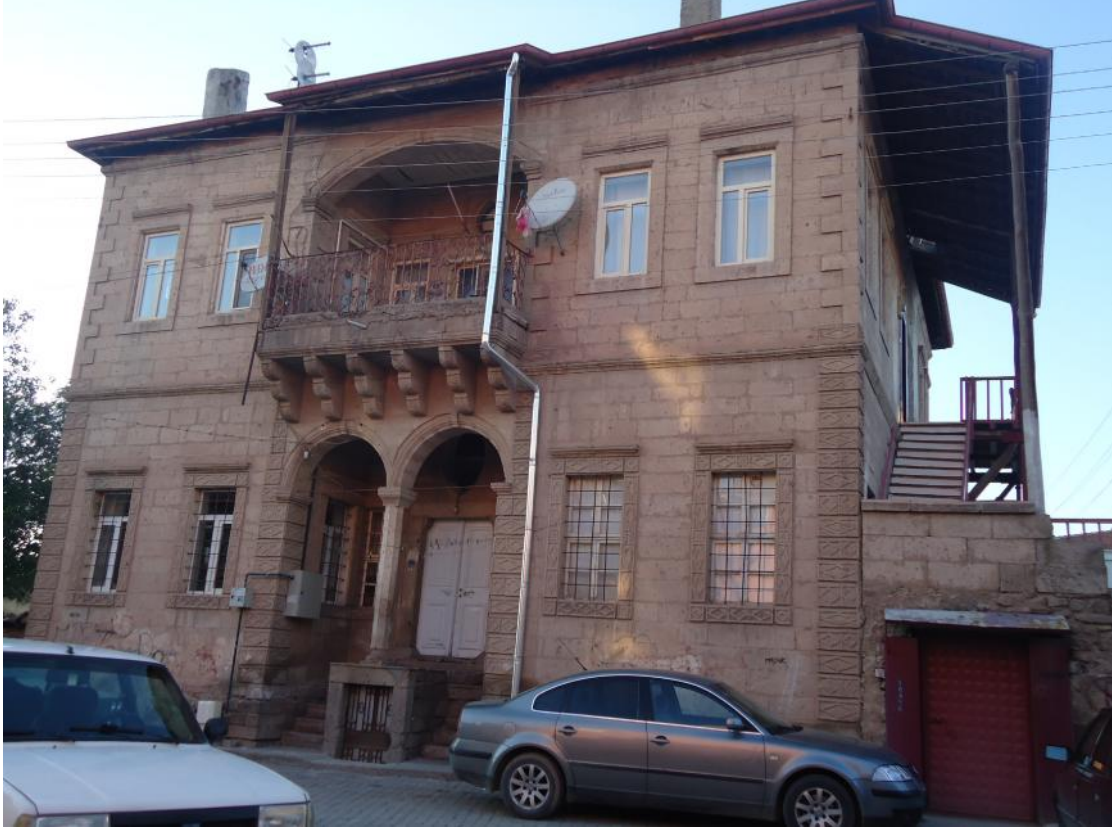
Şekil 5. 66 Aksaray İli'nin Merkez İlçesi'nin Taşpazar Mahallesi'nde bulunan Ünsallar Konağı'nın güney cephesi (Bediha Uğur).
