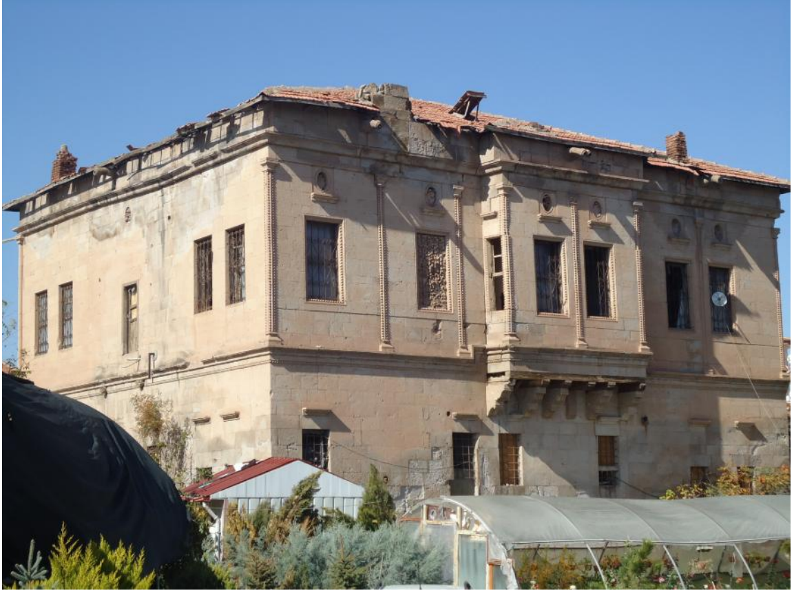
Şekil 5. 65 Perekler Konağı'nın doğu cephesi (Bediha Uğur).
