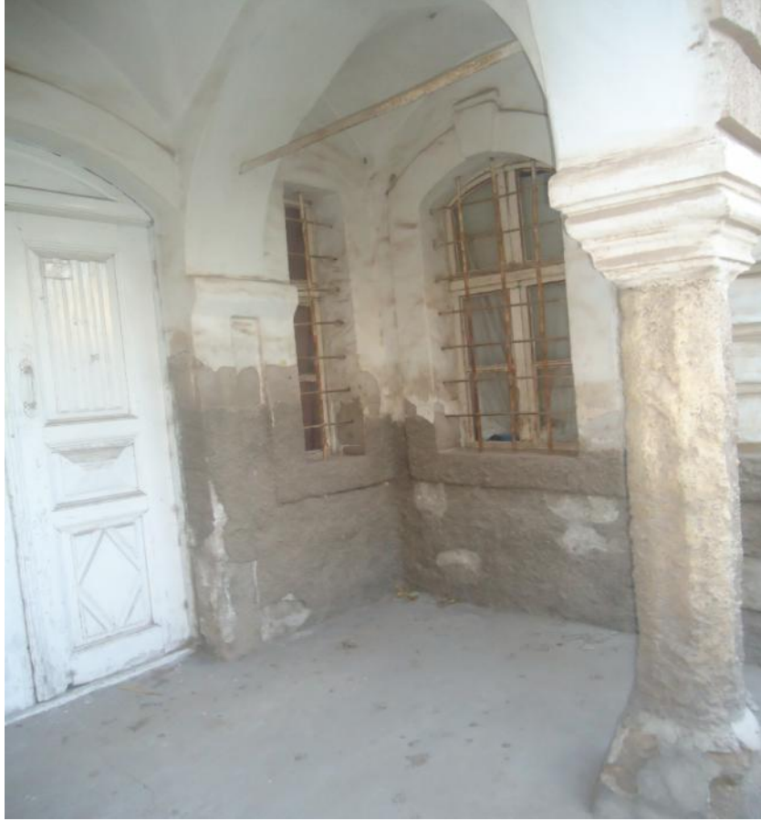
Şekil 5. 133 Çorakçılar Konağı'nın zemin katında bulunan ahşaptan yapılmış kapı ve pencereleri (Bediha Uğur).
