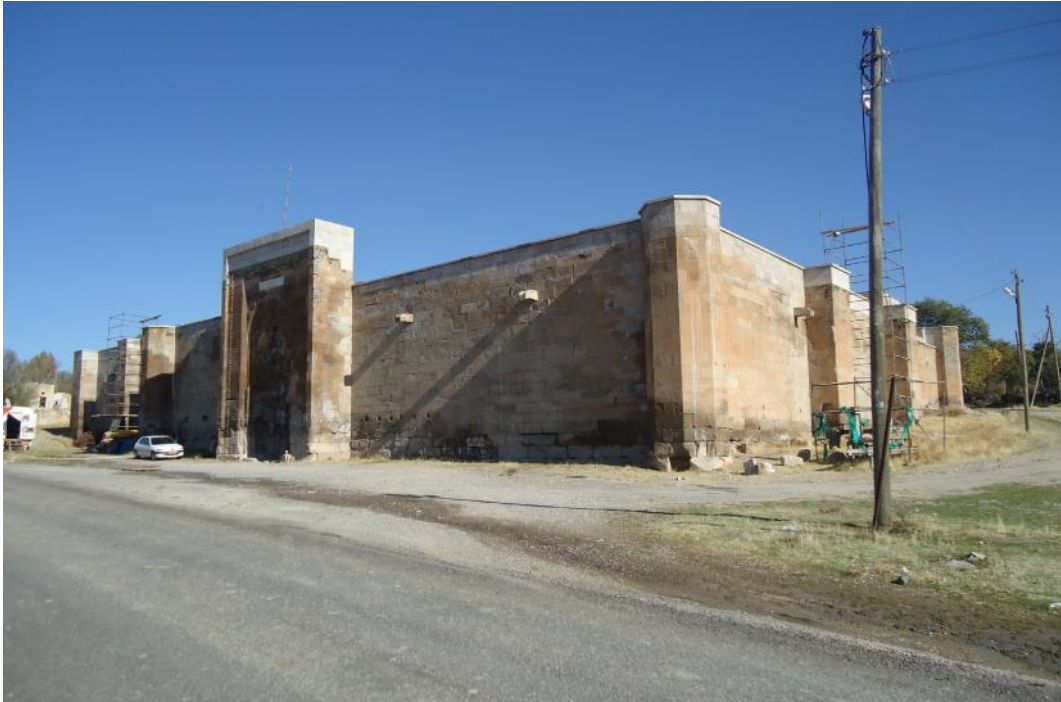
Şekil 5. 47 Ağzıkarahan'ın günümüzdeki hali (Bediha Uğur). Ağzıkarahan'ın duvarları kesme taş kullanılarak onarılmıştır.
