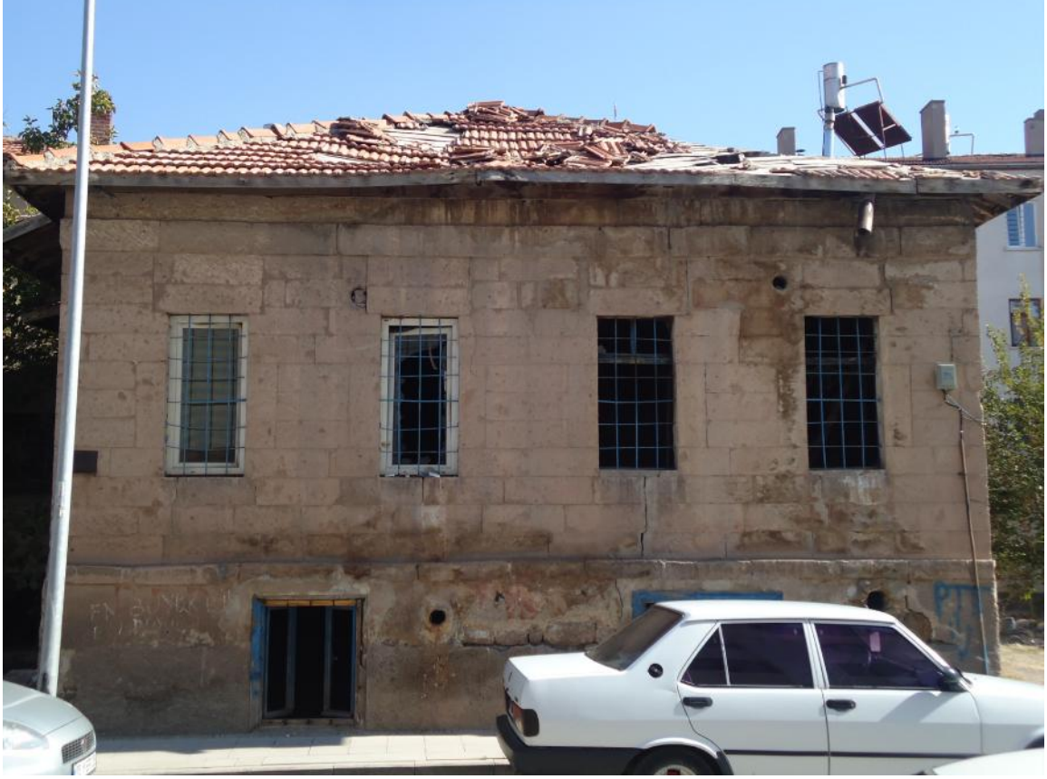
Şekil 5. 77 Aksaray İli'nin Merkez İlçesi'nin Paşacık Mahallesi'nde bulunan konağın güney cephesi (Bediha Uğur).
