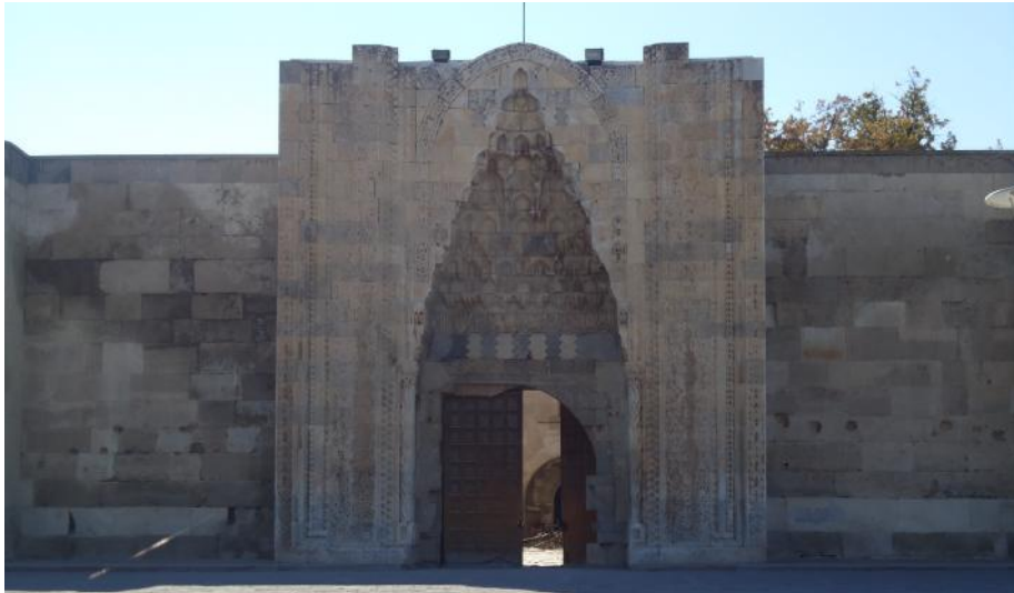
Şekil 5. 45 Sultan Han 'ın girişi (mermerden yapılmış taç kapısı) (Bediha Uğur).
