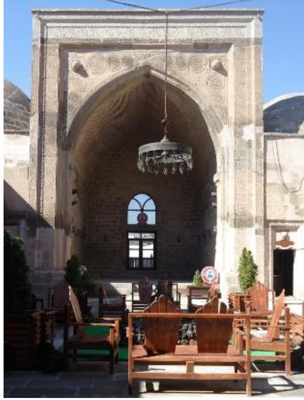
Şekil 5. 37 Zinciriye Medresesi'nin ana eyvanının günümüzdeki hali (Bediha Uğur). Zinciriye Medresesi'nin ana eyvanı kesme taş ve tuğla kullanılarak onarılmıştır.
