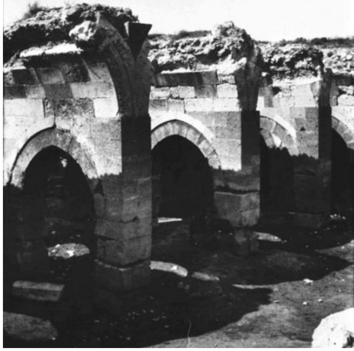
Şekil 5. 42 Sultan Han 'ın (açık kısmın) avlusunda bulunan kemerlerin onarım görmeden önceki hali ( http://www.acekli68.com/eski-aksaray-resimleri2-t3955.0.html ) (02. 06. 2013).
