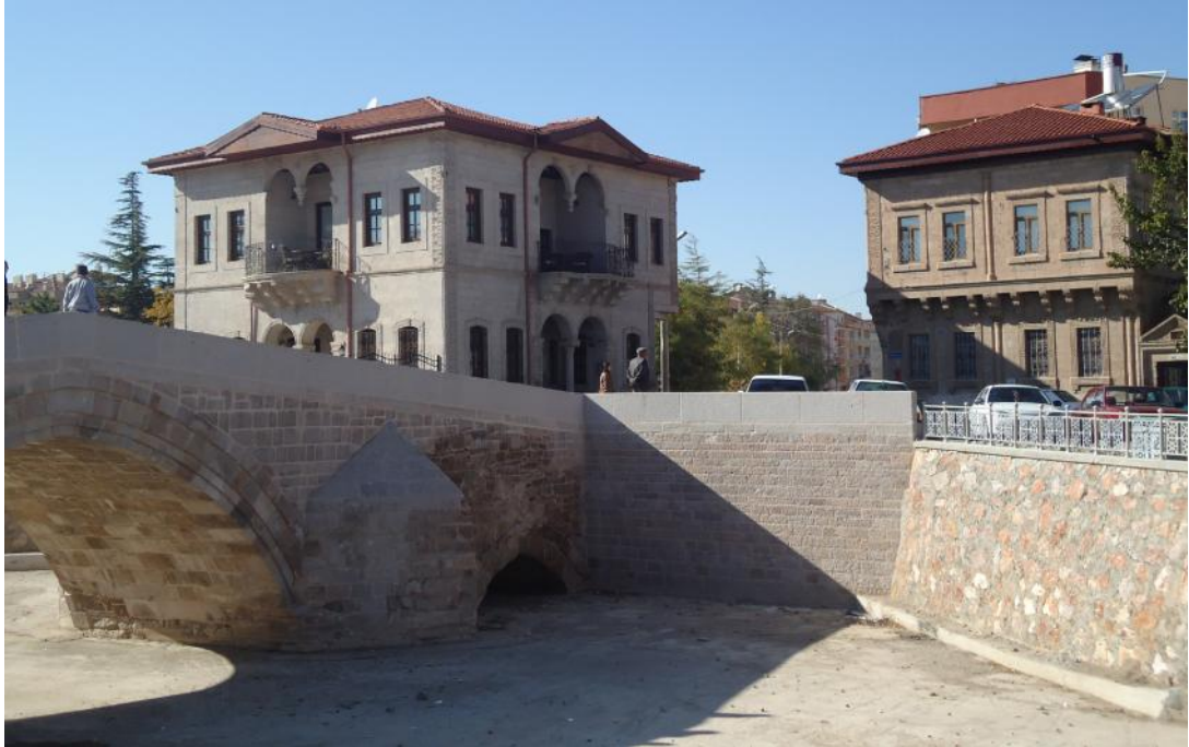
Şekil 5. 70 Baş Köprü (Bölcek Köprüsü) ve Akata ile İbrahim Kaya Konağı (Bediha Uğur).
