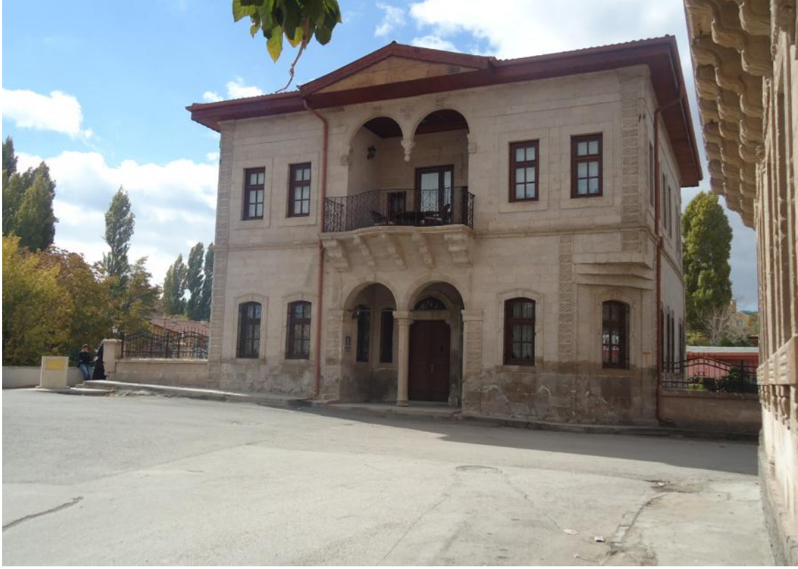
Şekil 5. 71 Aksaray İli'nin Merkez İlçesi'nin Kızıl Minare Mahallesi'nde bulunan İbrahim Kaya Konağı'nın batı cephesi (Bediha Uğur).
