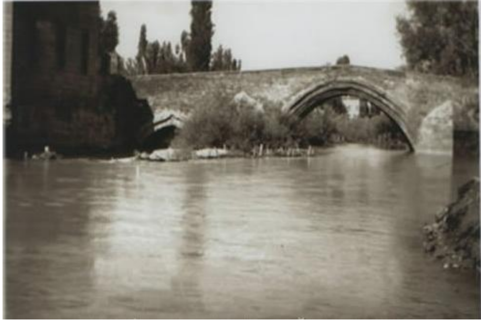
Şekil 5. 10 Aksaray İli'nin Merkez İlçesi'nin Kalanlar Mahallesi'nde bulunan Kalanlar Köprüsü'nün onarım görmeden önceki hali
