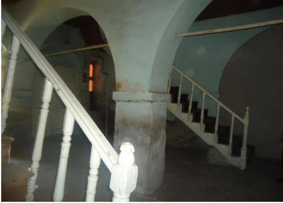
Şekil 5. 106 Çorakçılar Konağı'nın zemin katında bulunan merdivenler (Bediha Uğur).
