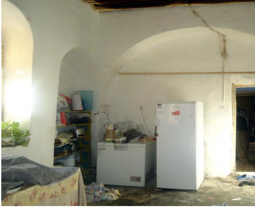
Şekil 5. 95 Çorakçılar Konağı'nın zemin katında bulunan mutfak (Bediha Uğur).
