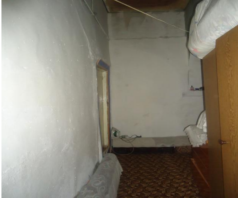
Şekil 5. 99 Çorakçılar Konağı'nın zemin katında bulunan koridor (Bediha Uğur).
