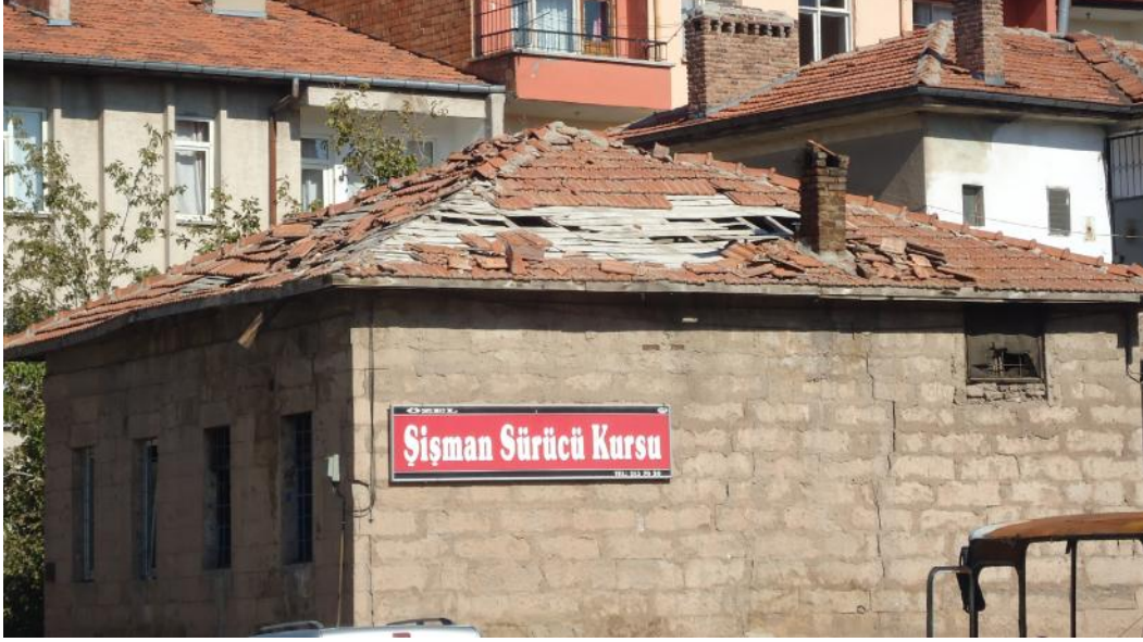
Şekil 5. 78 Aksaray İli'nin Merkez İlçesi'nin Paşacık Mahallesi'nde bulunan konağın çatısı (Bediha Uğur).
