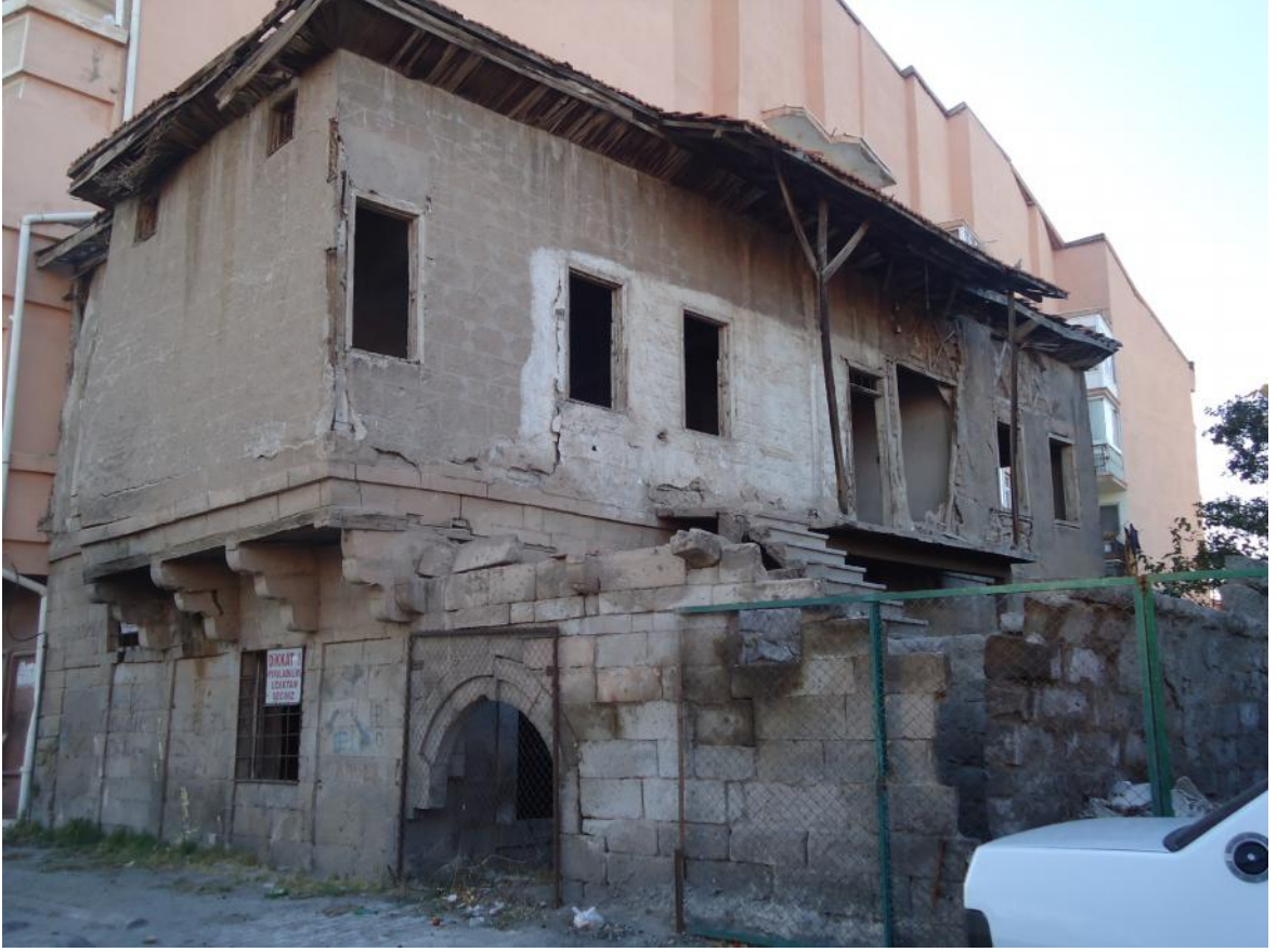
Şekil 5. 80 Aksaray İli'nin Merkez İlçesi'nin Taşpazar Mahallesi'nde bulunan konağın kuzey cephesi (Bediha Uğur).
