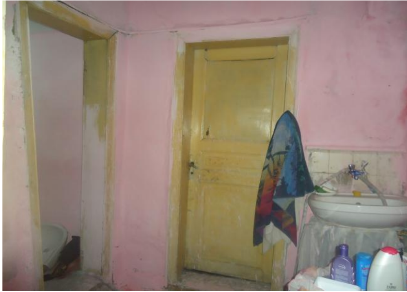
Şekil 5. 104 Çorakçılar Konağı'nın zemin katında bulunan banyo ve tuvaletin kapıları (Bediha Uğur).
