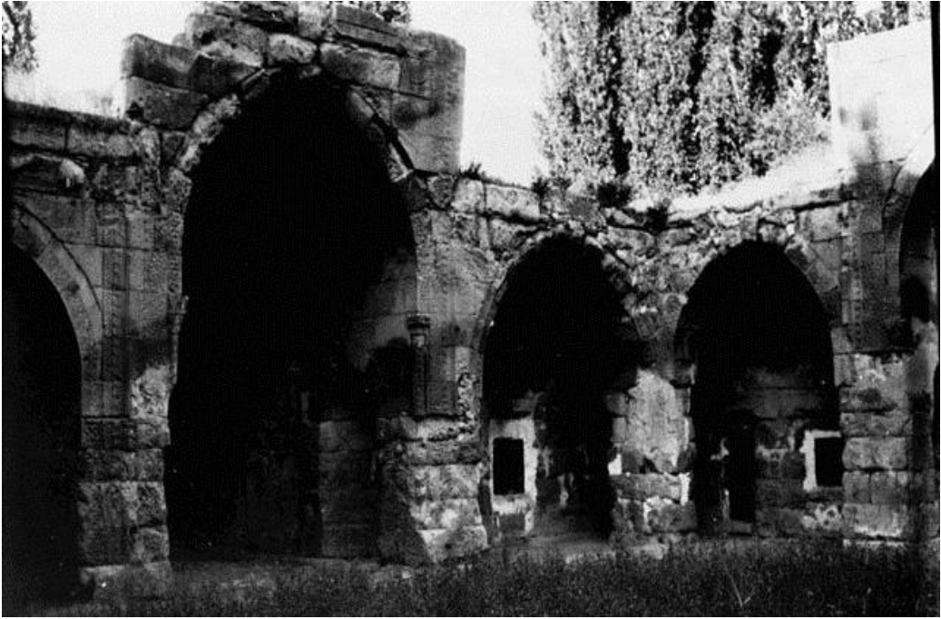
Şekil 5. 38 Zinciriye Medresesi'nin üstü açık avlusunun etrafında bulunan tonoz örtülü, değişik büyüklükte olan odaların onarım görmeden önceki hali ( http://www.acemli68.com/eski-aksaray-resimleri2-t3955.0.html ) (01. 06. 2013).
