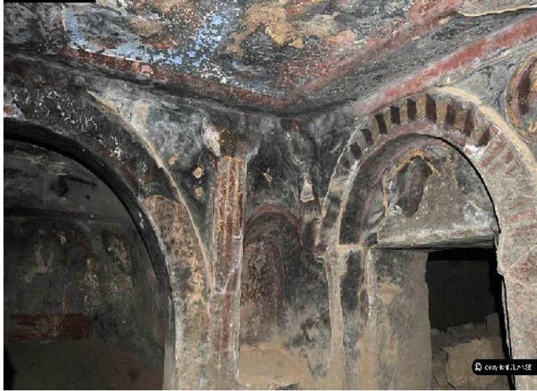
Şekil 5. 33 Karagedik Kilisesi'nin iç görünümü
