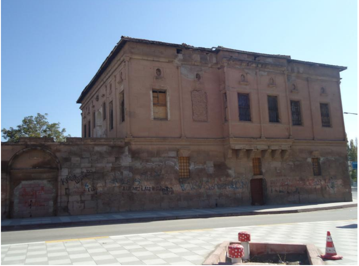
Şekil 5. 64 Aksaray İli'nin Merkez İlçesi'nin Kemeraltı Mahallesi'nde bulunan Perekler Konağı'nın batı cephesi (Bediha Uğur).
