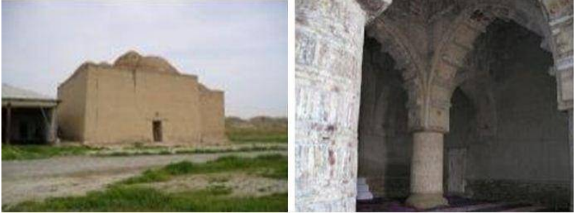
Şekil 6.1: Kışlak Hazara Cami
