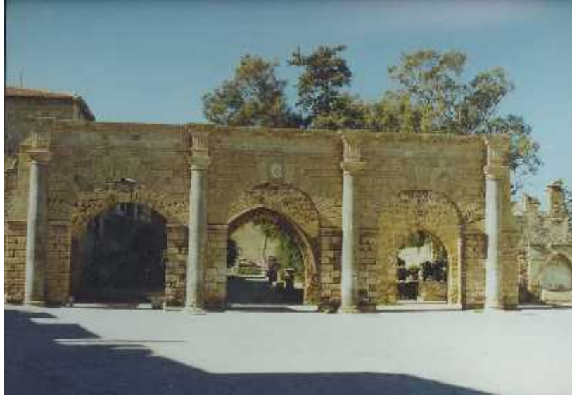
Resim 3.7: Mağusa Surlarında Luzinyan Sarayı
