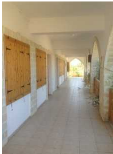
Resim 6.53: The Nitovikla Gardens'da kemerli revak
