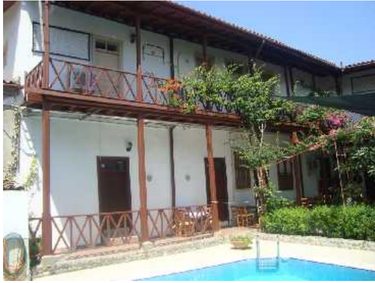
Resim 6.93: Lefke Gardens Hotel'in mevcut bloğunun iç bahçeden görünüşü
