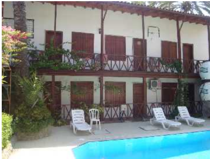
Resim 6.94: Lefke Gardens Hotel'in ilave bloğunun iç bahçeden görünüşü
