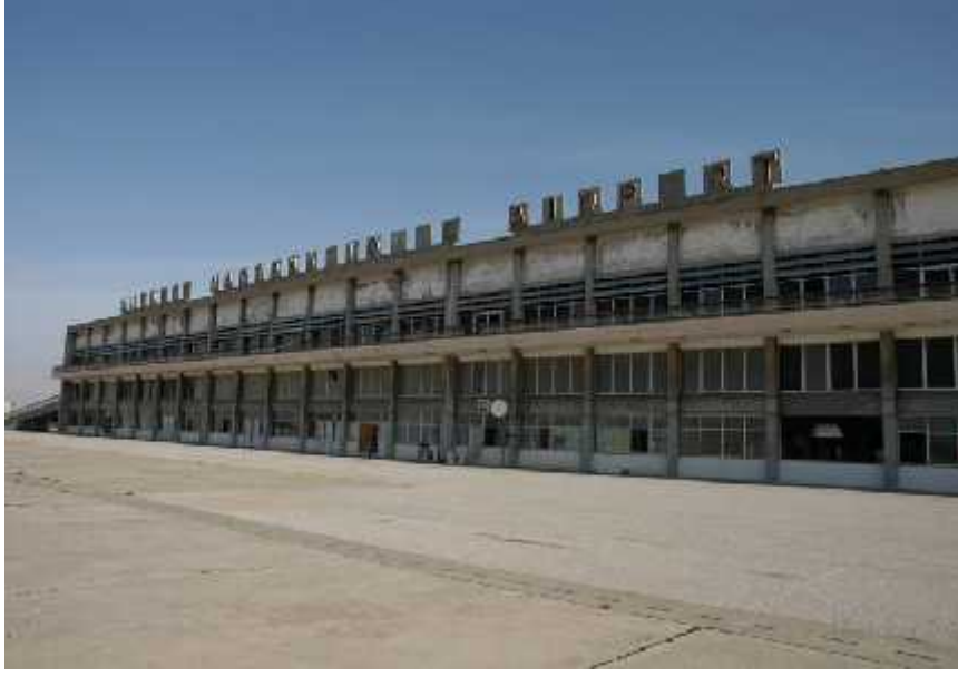
Resim 3.3: Lefkoşa Uluslararası Havaalanı
