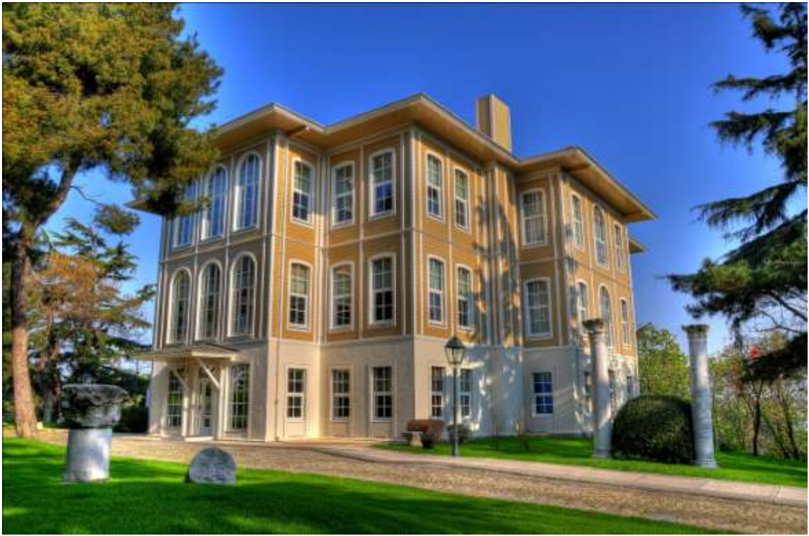
Resim 4.6: Nakkaştepe'deki Koç Holding Genel Merkez Binalarından biri ( http://www.koc.com.tr/en-us/Media_Center/VisualGallery/Lists/Fotograf/Attachments/7/DSC_0004_5_6.jpg )
