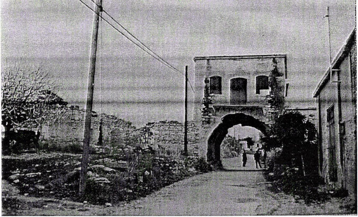
T3 No'lu Binanın Kuzey Görünüşü
