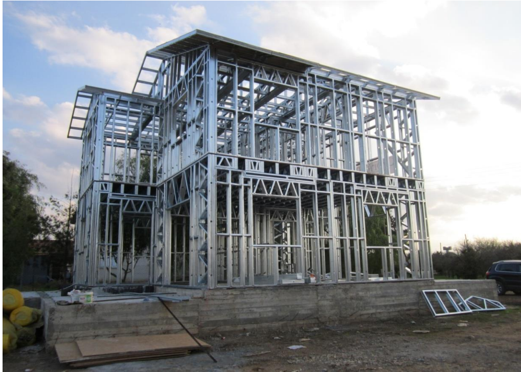
Resim 4.30 Cyprus Proev konut projesi yapım aşaması
