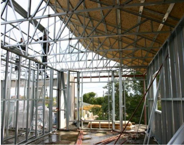
Resim 4.36 Duvar profillerinin kurulumu
