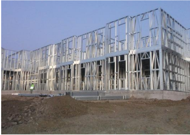
Resim 3.2 Van depremi sonrası yapılan ilk hafif çelik sistemli okul örneği
