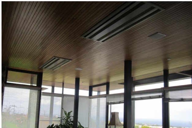
Resim 4.9 Soğutma sistemi ve kanada çamı asma tavan
