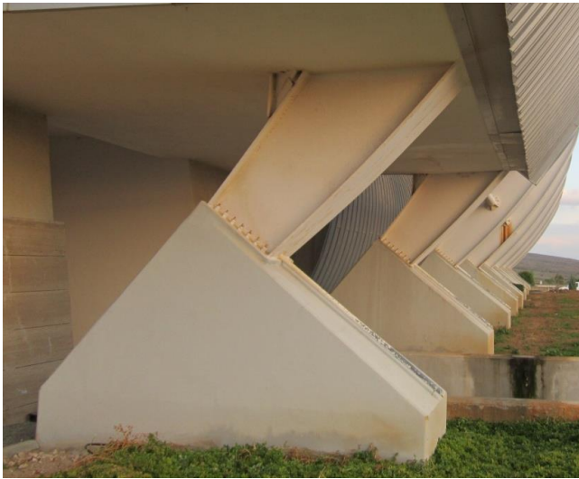
Resim 4.20 Çelik kolonların brüt betonla birleşimi
