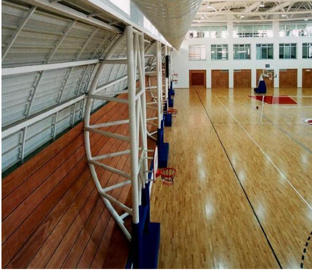
Resim 4.19 Eğrisel cepheyi taşıyan düşey makaslar http://v2.arkiv.com.tr/popup/watermark.php?src=21647.jpg
