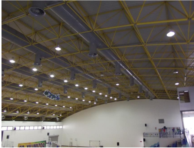
Rerim 4.26 UKS çatı görünüşü
