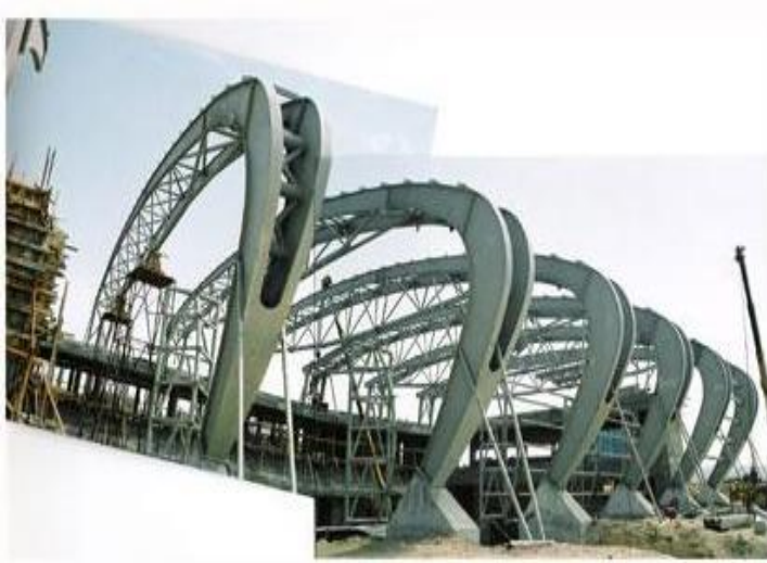
Resim 4.16 Yapının ana taşıyıcı sistemi ( http://v2.arkiv.com.tr/p7082 )
