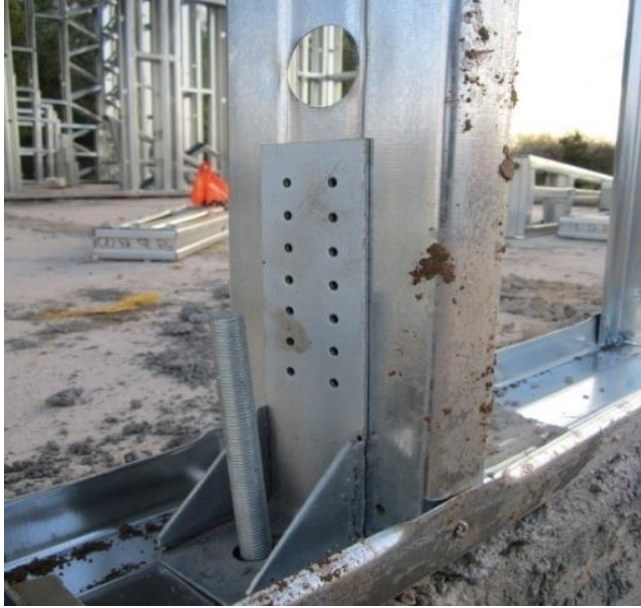
Resim 4.34 Çelik profil dikmelerin beton zemine montajı
