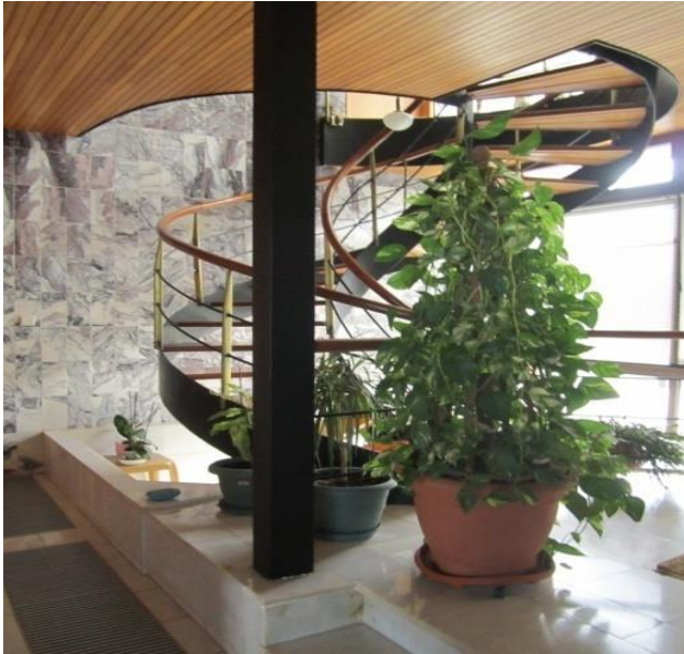
Resim 4.5 Çelik konstrüksiyon döner merdiven
