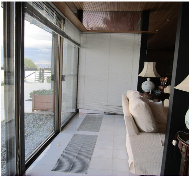
Resim 4.8 Cephedeki ısı camları ve döşemeye gömülmüş ısıtma sistemi
