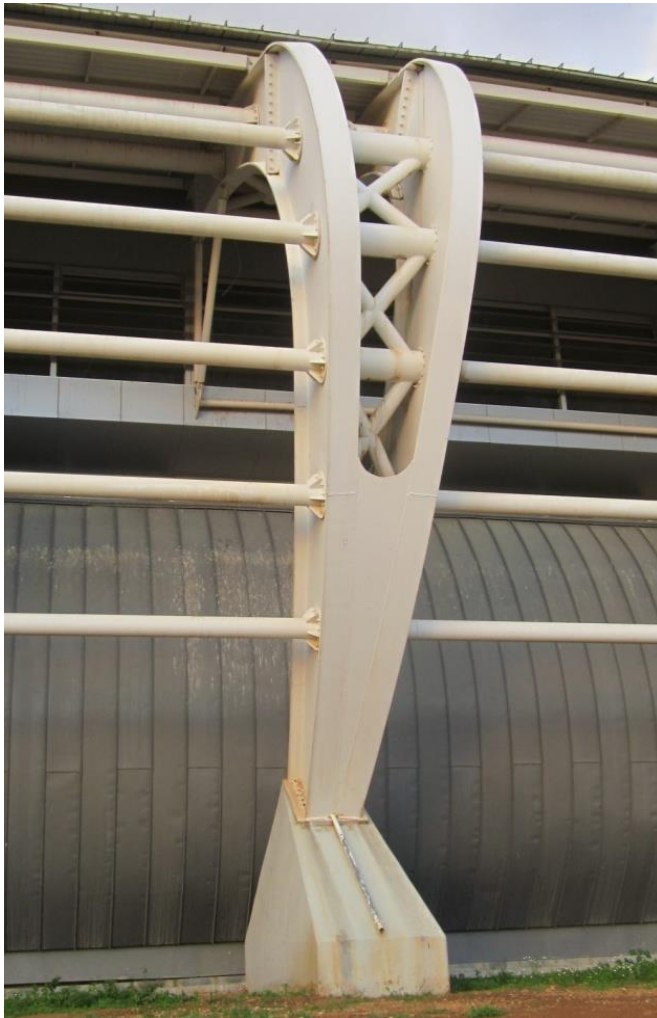
Resim 4.17 Çok parçalı çelik kolon
