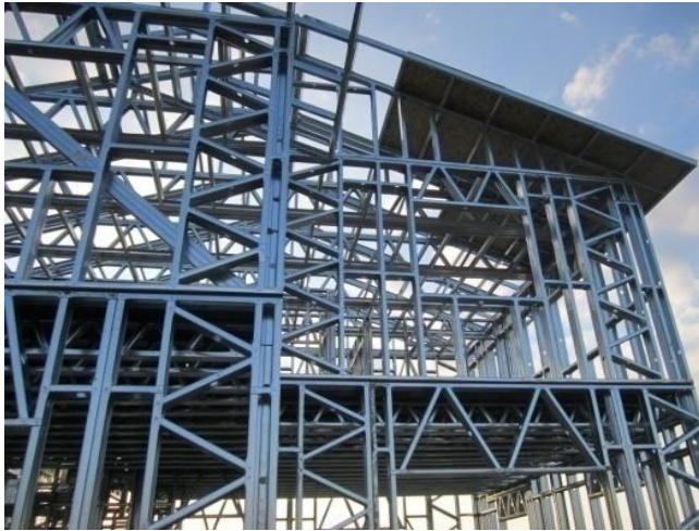
Resim 4.32 Kapı-pencere ve köşe çaprazlamaları
