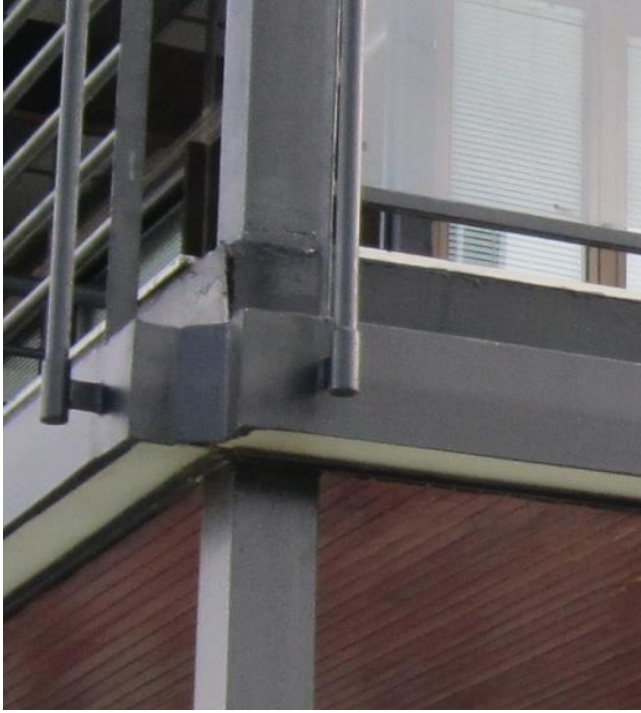
Resim 4.10 Döşemede kaynaklı birleşimler
