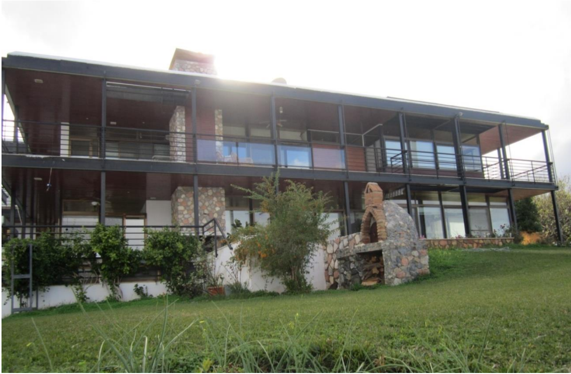
Resim 4.3 Toros Ailesi konut projesi kuzey cephesi
