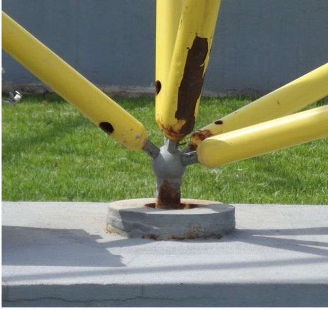
Resim 4.27 Profillerinde görülen paslama
