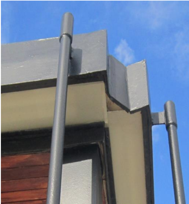
Resim 4.11 Çatıda kaynaklı birleşimler
