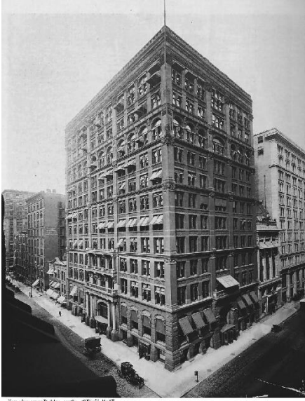
Resim 2.7 Home Insurance Binası (Chicago, 1885)
