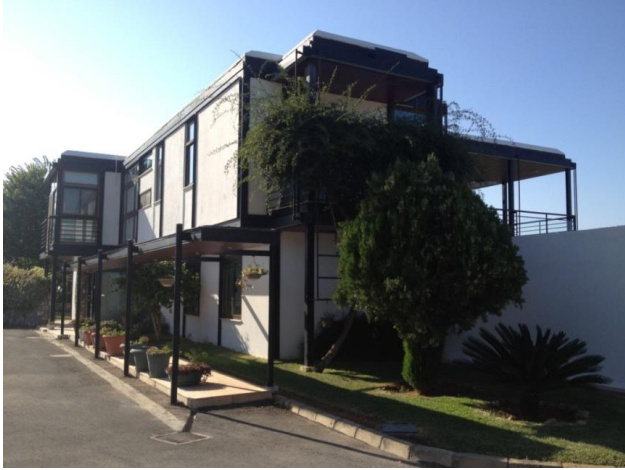
Resim 4.4 Güney (giriş) cephesi
