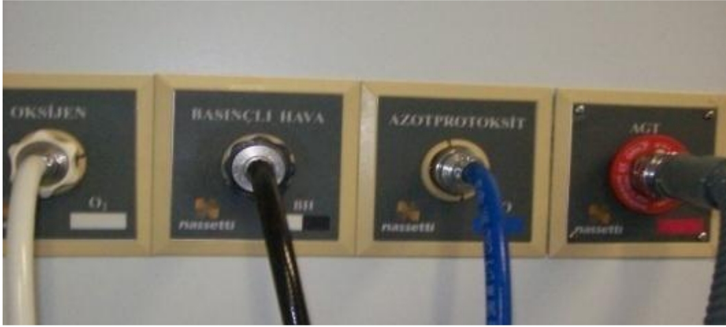
Şekil 4: hastane merkezi sistemden gelen gazlar (DİKMEN Yalım, Anestezinin Sırları, 2006)
