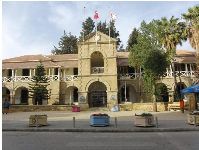
Şekil 3.38: Mahkemeler Binası (K.Bolkaner, 2018)
