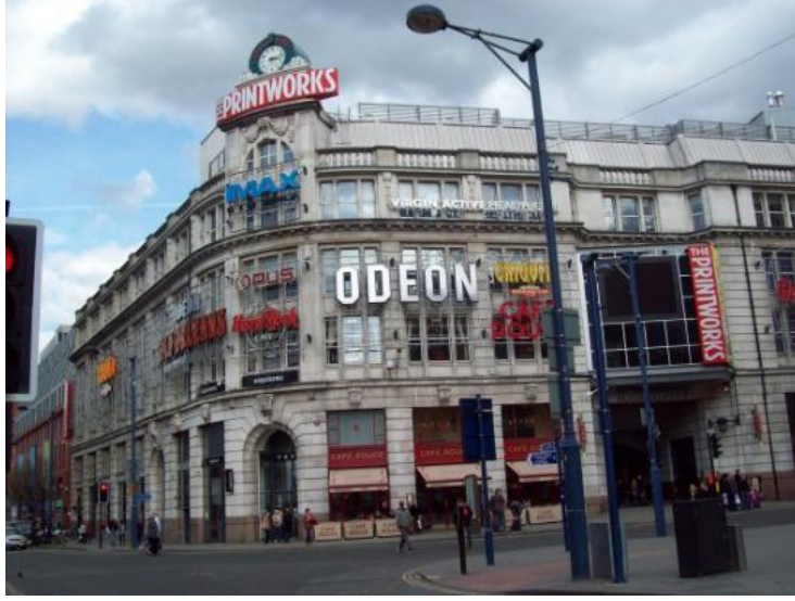
Şekil 2.12: 1996'da Manchester kent merkezinde patlayan bombanın ardından yapılan yenileme çalışmaları kapsamında, yeniden işlevlendirilen Printworks Binası (wikipedia, 2018)
