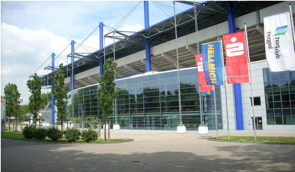
Şekil 3.5: MSV Arena stadyumu ön cephe (Kasap, 2012)
