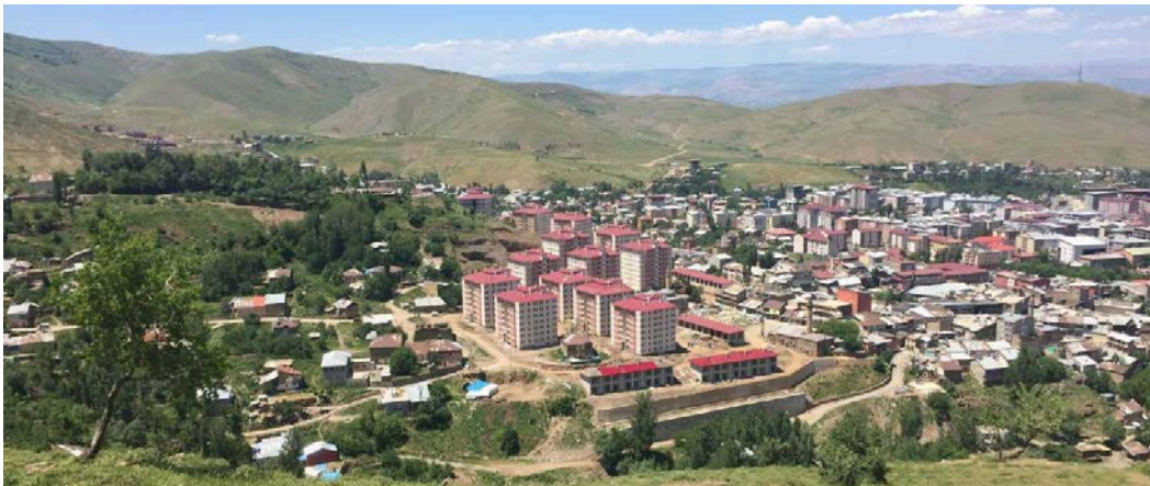
Şekil 4.9: Kale mahallesi kentsel dönüşüm projesi kapsamında toplu konutların yapım aşaması, güney tarafından bakış (Işık, 2017)
