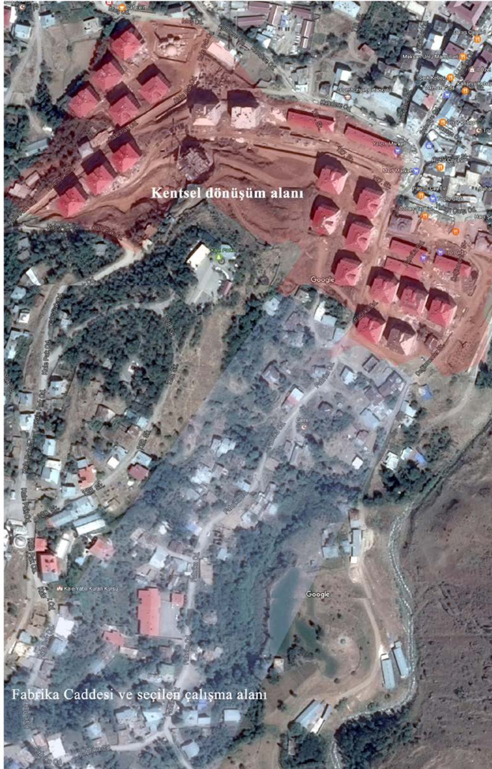
Şekil 4.3: Kentsel dönüşüm sonrası Kale Mahallesi uydu görüntüsü (Google Earth, nisan, 2017)
