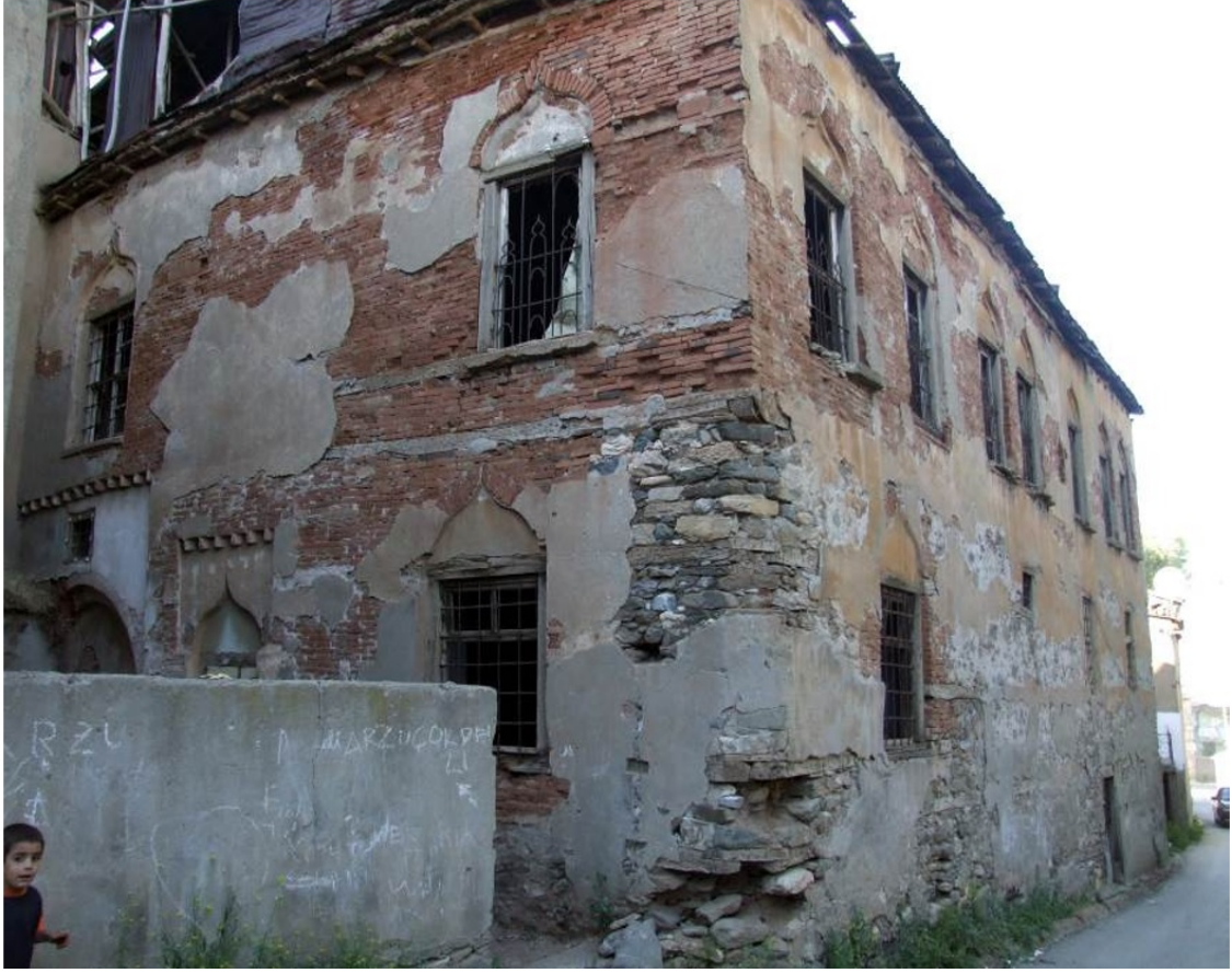
Şekil 3.11: Muş Kale mahallesi geleneksel konutunda malzeme kullanımı (Kılavuz, 2013)
