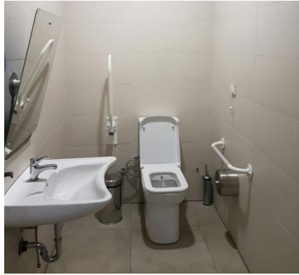
Şekil 5.23: Engelli tuvalet ve lavabosu
