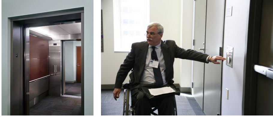
Şekil 5.5: Asansör ve yangına dayanıklı kapılara sahip sığınma alanı girişi (Access Living, 2016)
