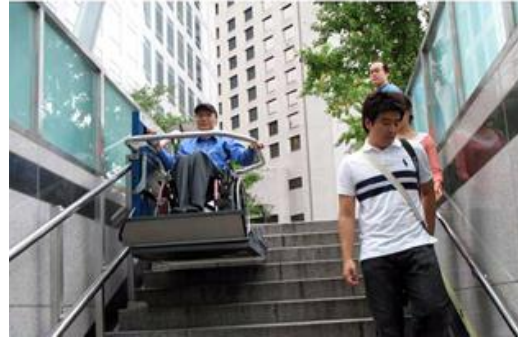
Şekil 3.9: TS 12576'da bulunan, rampa yapılamaması durumunda tercih edilebilecek eğik asansör (Gültaşlı, 2017)
