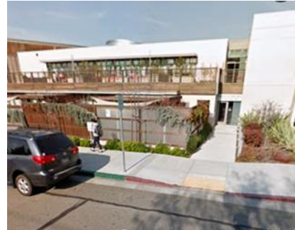
(b) Güney cephesi giriş kapısı (Google Earth, 2016)
