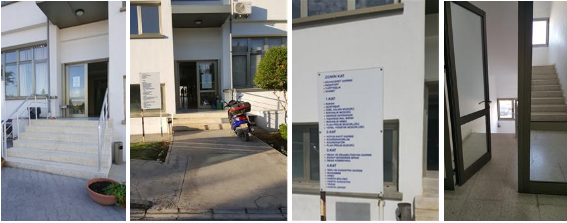
Şekil 6.9: Sağ ve sol yan cephe giriş kapıları, katlarla ilgili bilgi verici levha ve bu girişlerin yanlarındaki merdivenler
