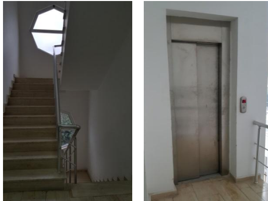
Şekil 5.34: Bina içerisinde bulunan merdiven ve asansör
