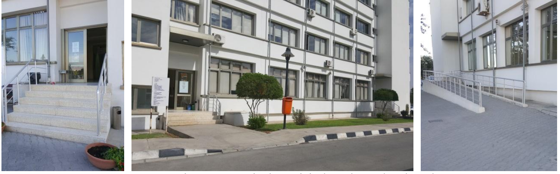
Şekil 6.7: Binanın zemin kat giriş kapılarından bazıları
