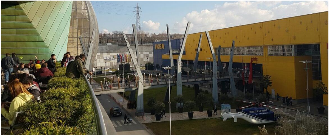
Şekil 5.17: Güney cephesi girişi ve mobilya mağazası ile bağlantı kurulan köprü
