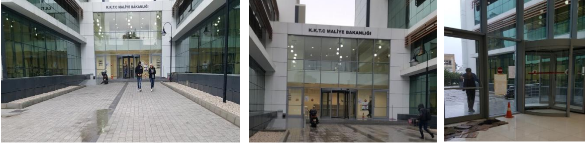
Şekil 5.26: Bina çevresindeki kaldırımlar, giriş kapısı ile kaldırım bağlantısı ve giriş kapıları
