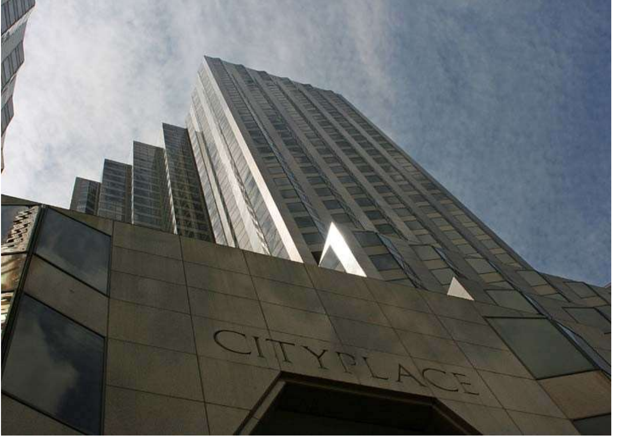
Şekil 2.2: İlk akıllı bina City Place'ın önden görünümü (Atasoy, 2009).
