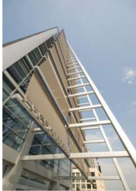
Şekil 5.23: Abdi İbrahim Tower dış cephe detayından görünüm (Abdi İbrahim Tower Arşiv, 2018).
