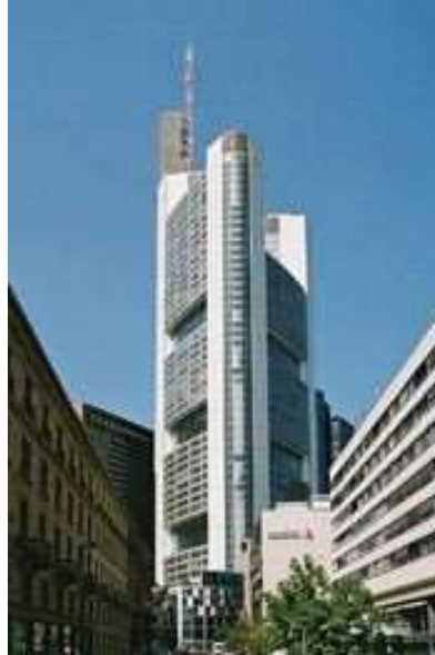
Şekil 2.5: Commerzbank Genel Müdürlük Binası (Dayangaç, 2005).
