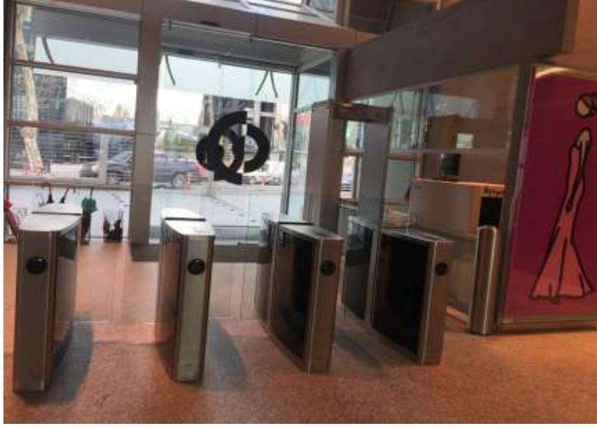
Şekil 5.3: Abdi İbrahim Tower giriş turnikelerinden görünüm (Aksoy, 2018).
