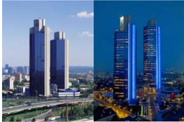
Şekil 2.16: Sabancı Center binası gündüz ve gece görünümü ( www.lightworld.com.tr ).
