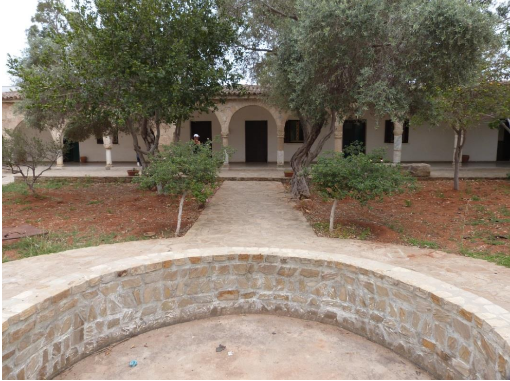
Görüntü 57: Merkezi avlu içerisinde yönlendirme işaretçileri kullanılmadığı gözlemlenmiştir, Fotoğraf: Serkad Hasan Işıkören
