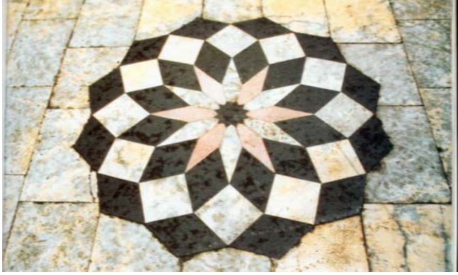
Şekil 3. 52: 52 Numaralı evin bahçe taban döşemesi (Osmanlıoğlu, 2018)
