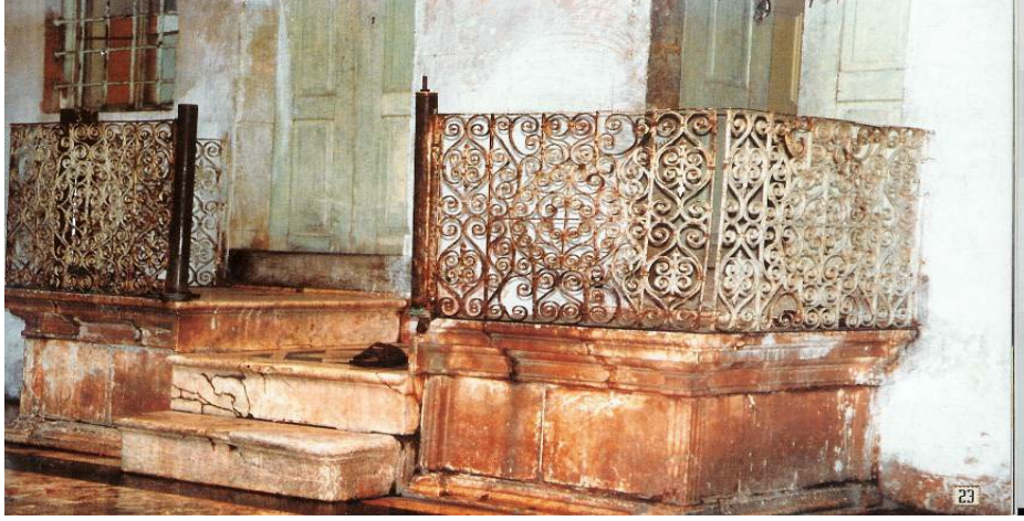
Şekil 3. 7: 7 Numaralı evin giriş merdiveninin korkuluğundaki demir işçiliği (Osmanlıoğlu, 2018)
