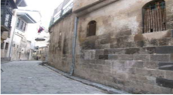
Şekil 6: Sokak Görünümü (Osmanlıoğlu, 2018)
