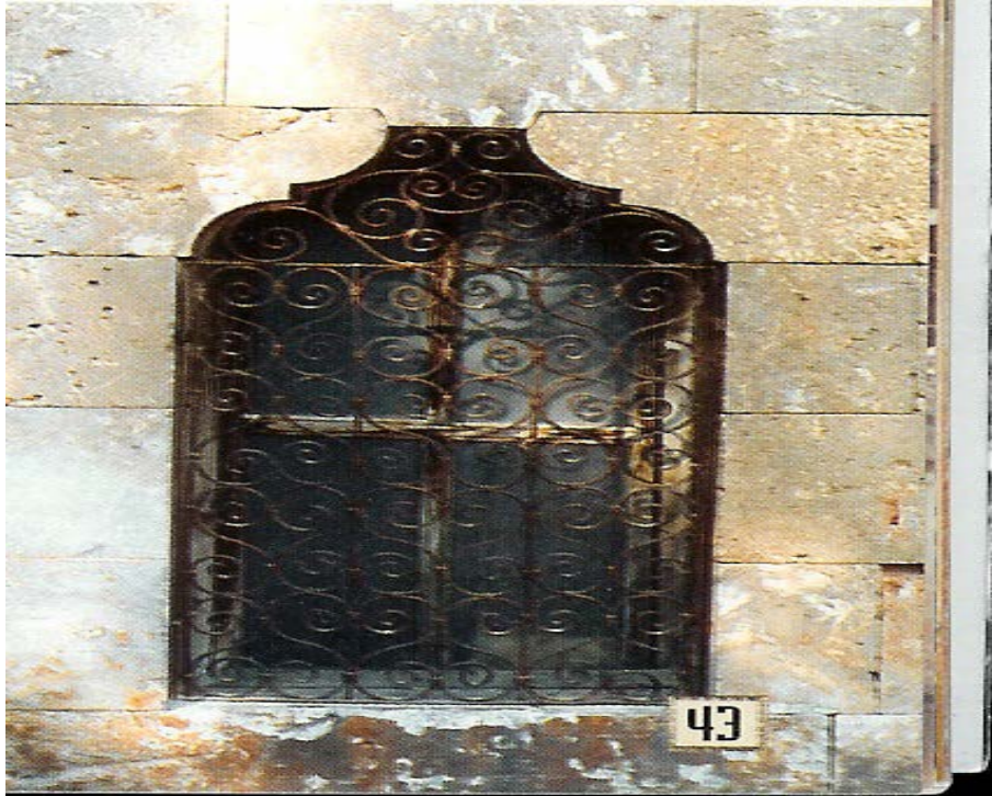
Şekil 3. 22: 22 Numaralı evin bodrum penceresi (Osmanlıoğlu, 2018)
