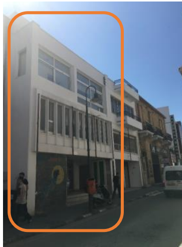
Şekil 4.17: 144-140/1 nolu binanın dış görünüşü (Anıl, 2016)
