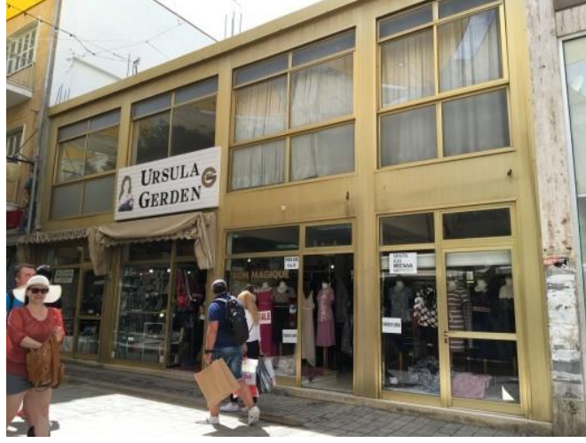
Şekil 4.77: 204 nolu binanın dış görünüşü (Anıl, 2016)
