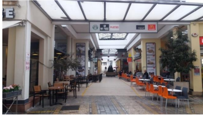
Şekil 4.85: Ledra Arcade arka cephe (Anıl, 2016)
