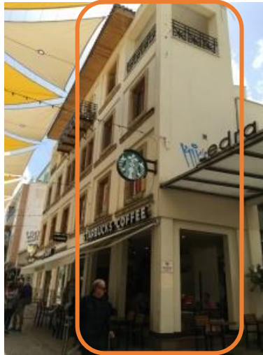
Şekil 4.83: 204 nolu binanın dış görünüşü (Anıl, 2016)
