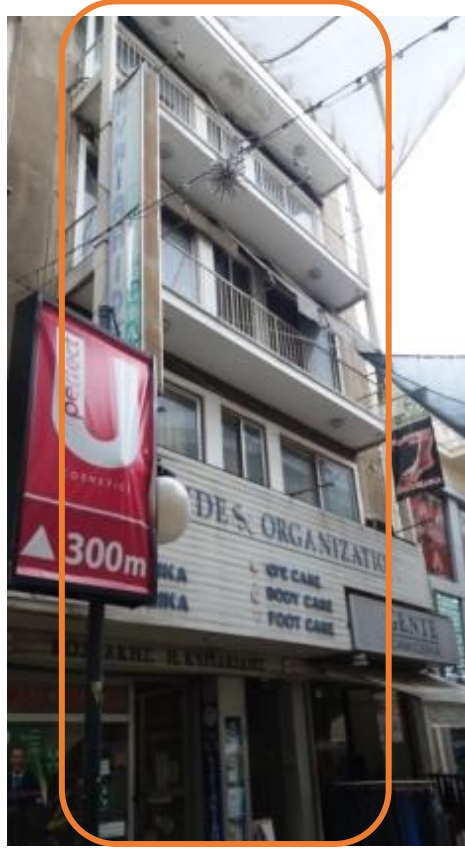
Şekil 4.67: 256/A nolu binanın dış görünüşü (Anıl, 2016)
