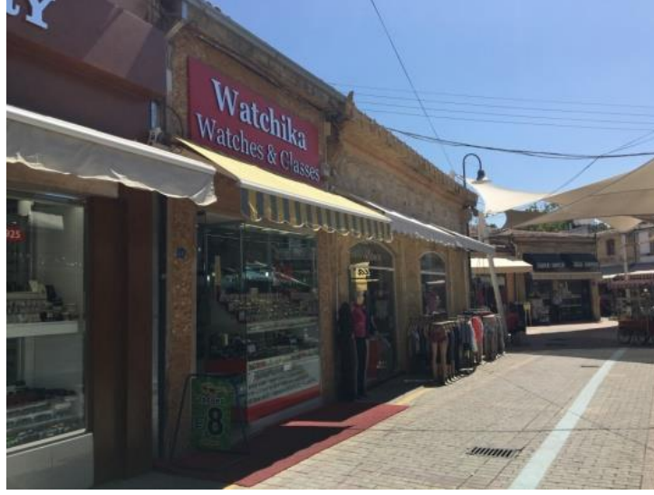
Şekil 4.137: No: 28-7-9 binaların dış görünüşü (Anıl, 2016)
