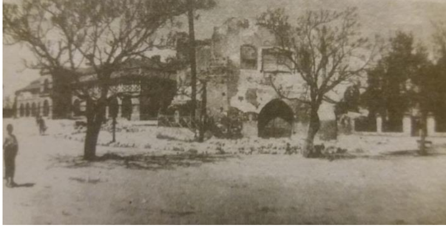
Şekil 4.157: Lüzinyan Sarayı ve Hükümet Konağı 1904 (Ufuk Gazi, 2013)
