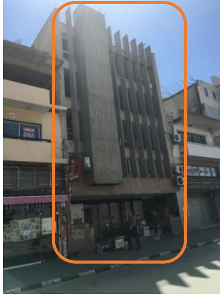
Şekil 4.23: 114 nolu binanın dış görünüşü (Anıl, 2016)
