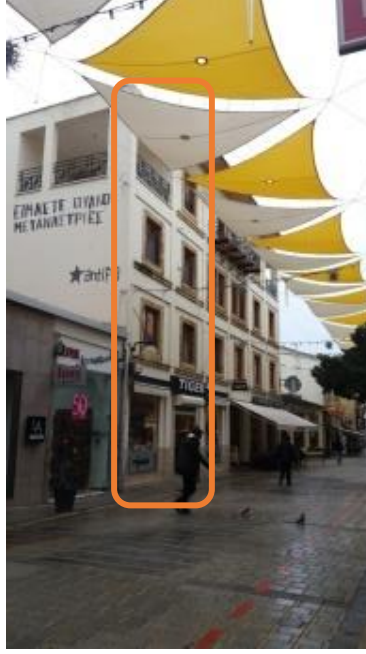
Şekil 4.82: 238/A nolu binanın dış görünüşü (Anıl, 2016)
