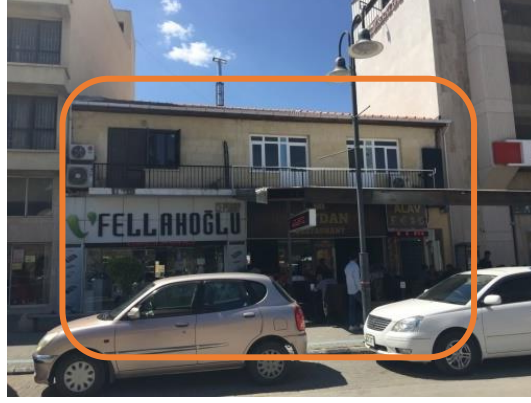
Şekil 4.130: 97-99 nolu binanın dış görünüşü (Anıl, 2016)
