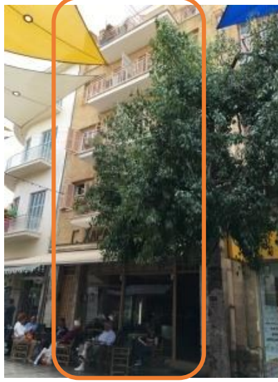
Şekil 4.94: 118 nolu binanın dış görünüşü (Anıl, 2016)
