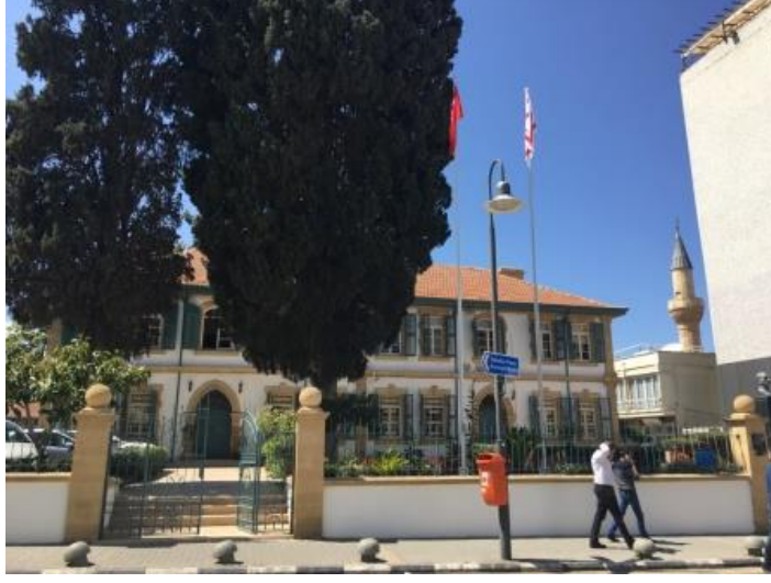
Şekil 4.112: 11 nolu yapı Vakıflar (Evkaf) (Anıl, 2016)
