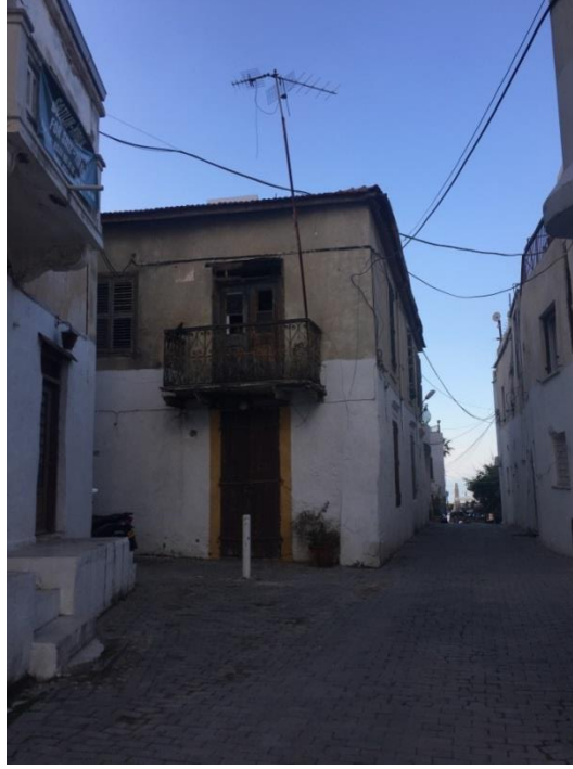
Resim 3.10: Taş malzemenin sıva ile kaplanıp boyanması (Yazar)
