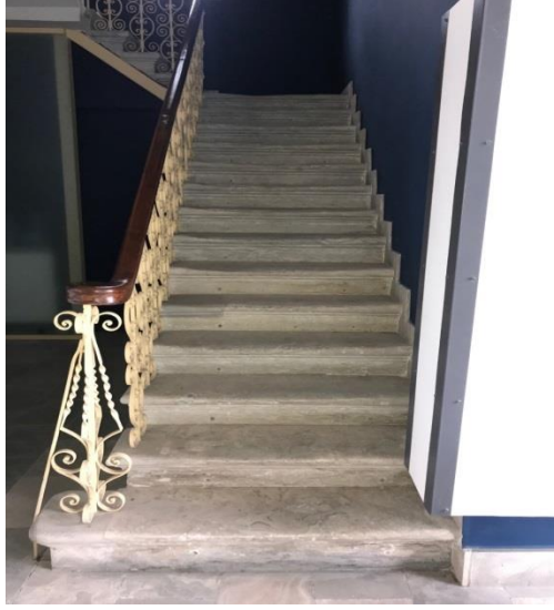
Şekil 4.93: İTÜ Sürekli Eğitim Merkezi Binası merdiveni (Koşanlar, 2018)
