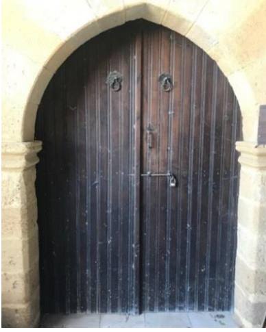
Şekil 4.134: Lüzinyan Evi alt kat oda kapısı (Koşanlar, 2018)
