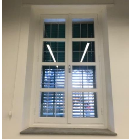
Şekil 4.97: İTÜ Sürekli Eğitim Merkezi Binası alt kat oda penceresi (Koşanlar, 2018)
