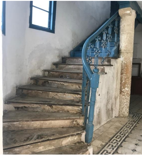
řekil 4.183: Hasder Binası merdiveni (Kořanlar, 2019)
