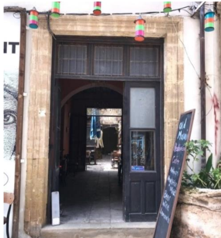
Şekil 4.216: Mosaic Lokanta Binası zemin kat oda kapısı (Koşanlar, 2019)
