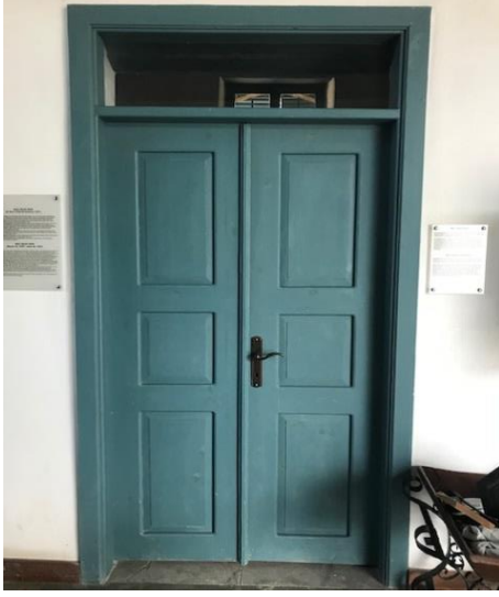
Şekil 4.112: Naci Talat Vakfı Binası alt kat oda kapısı (Koşanlar, 2018)
