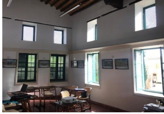
Şekil 4.83: Yunus Emre Enstitüsü Binası’nda sergen (Koşanlar, 2018)
