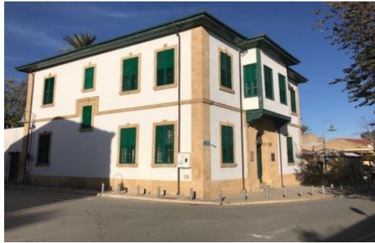
Şekil 4.91: İTÜ Sürekli Eğitim Merkezi Binası (Koşanlar, 2018)
