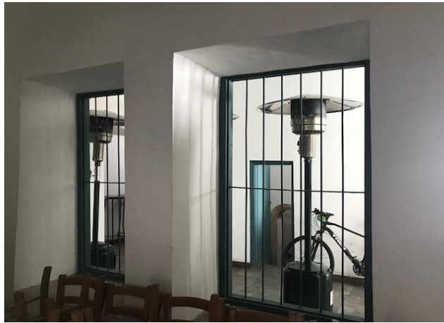
Şekil 4.114: Naci Talat Vakfı Binası alt katta pencere açıklıkları (Koşanlar, 2018)
