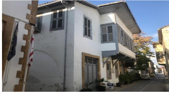
Şekil 4.150: Bohcalian Konağı (Koşanlar, 2018)
