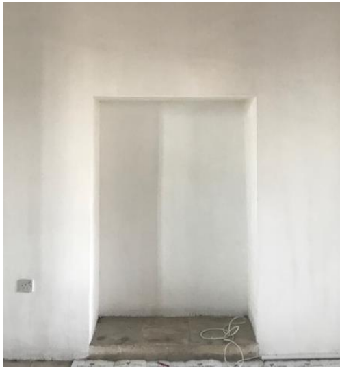
Şekil 4.138: Lüzinyan Evi'nde duvar nişi (Koşanlar, 2018)
