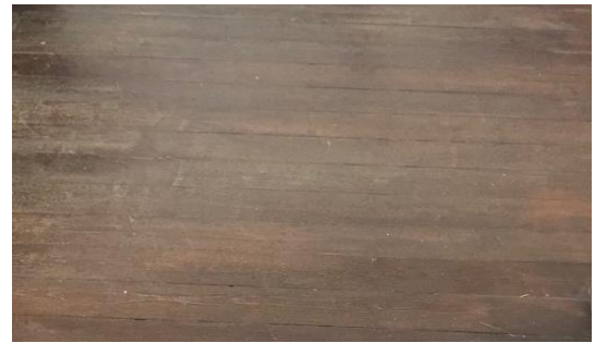
Şekil 4.29: Kadı Menteşoğlu Konağı üst kat oda döşemesi (Koşanlar, 2018)
