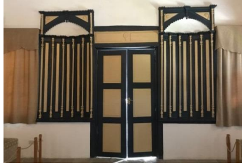
Şekil 4.20: Derviş Paşa Konağı Başodada lambalık nişi (Koşanlar, 2018)
