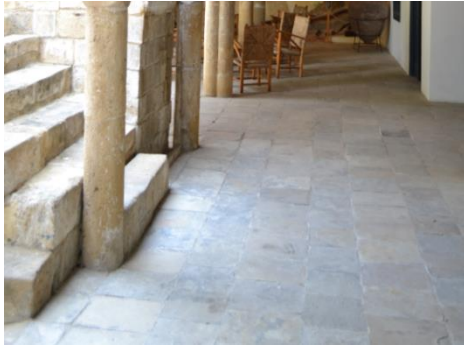
Şekil 4.2: Derviş Paşa Konağı alt kat sofası (Koşanlar, 2018)
