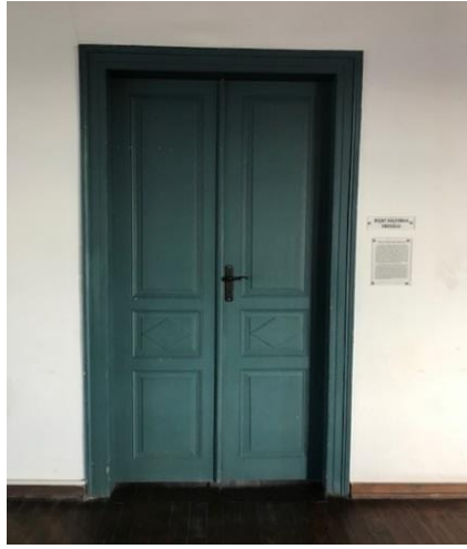
Şekil 4.118: Naci Talat Vakfı Binası üst katta oda kapısı (Koşanlar, 2018)
