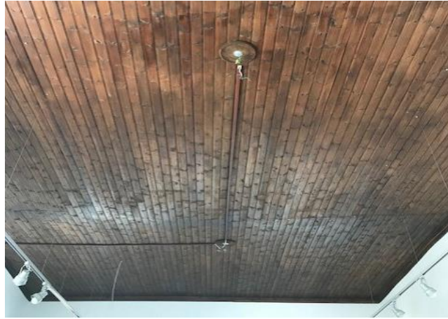
Şekil 4.125: Naci Talat Vakfı Binası üst kat sofa tavanı (Koşanlar, 2018)
