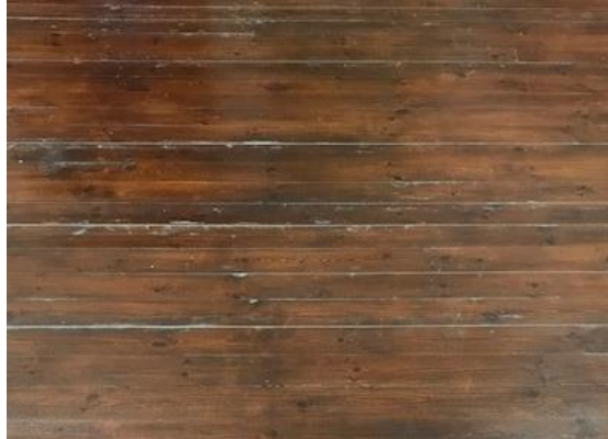
Şekil 4.94: İTÜ Sürekli Eğitim Merkezi Binası üst kat döşemesi (Koşanlar, 2018)
