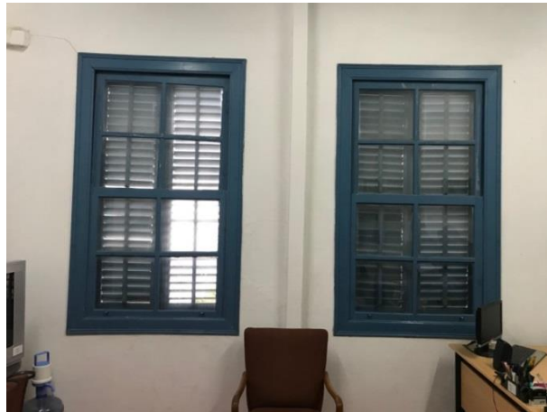
Şekil 4.193: Hasder Binası giyotin tipindeki üst kat oda pencereleri (Koşanlar, 2019)
