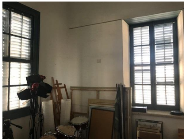
Şekil 4.120: Naci Talat Vakfı Binası üst kat oda pencereleri (Koşanlar, 2018)
