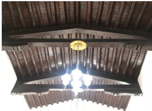
Şekil 4.90: Yunus Emre Enstitüsü Binası Başoda tavanı (Koşanlar, 2018)
