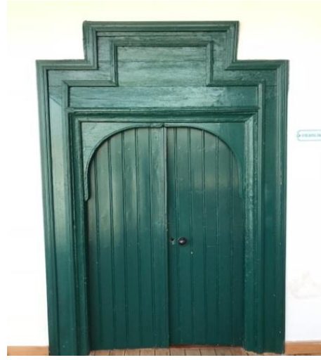
Şekil 4.80: Yunus Emre Enstitüsü Binası üst kat oda kapısı (Koşanlar, 2018)
