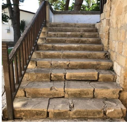
Şekil 4.27: Kadı Menteşoğlu Konağı merdiveni (Koşanlar, 2018)
