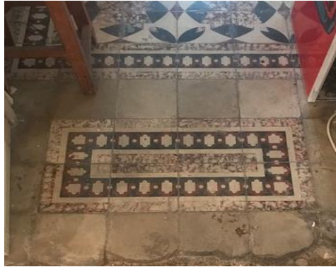
Şekil 4.151: Bohcalian Konağı alt kat sofa döşemesi (Koşanlar, 2018)
