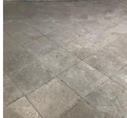
Şekil 4.131: Lüzinyan Evi eyvan zemini (Koşanlar, 2018)
