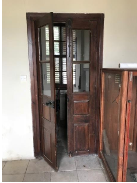
Şekil 4.175: Zahra Sokak No.4 çıkmalı oda kapısı (Koşanlar, 2018)
