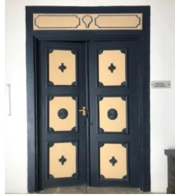
Şekil 4.17: Derviş Paşa Konağı Başoda kapısı (Koşanlar, 2018)
