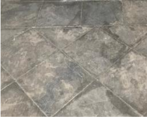
Şekil 4.107: Naci Talat Vakfı Binası alt kat sofa zemini (Koşanlar, 2018)
