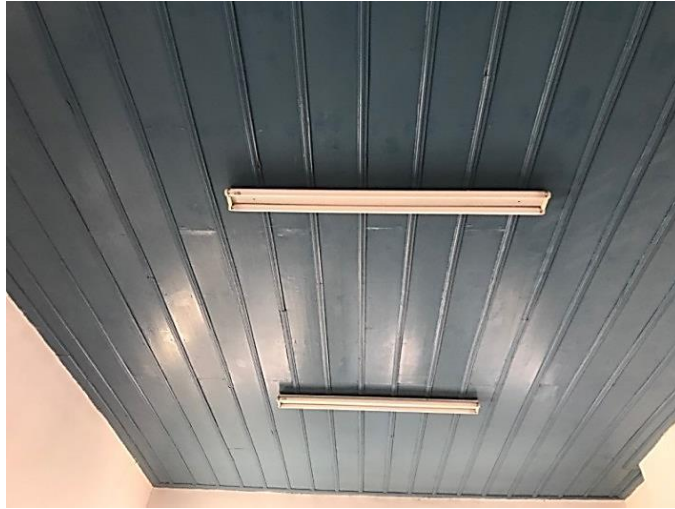
Şekil 4.199: Hasder Binası Başoda tavanı (Koşanlar, 2018)
