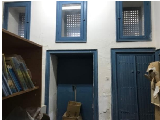
Şekil 4.190: Hasder Binası alt kat sofaya açılan tepe pencereleri (Koşanlar, 2019)
