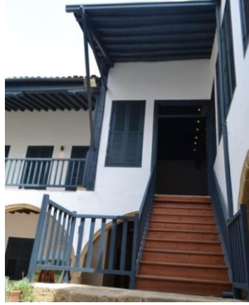
Şekil 4.4: Derviş Paşa Konağı merdiveni (Koşanlar, 2018)
