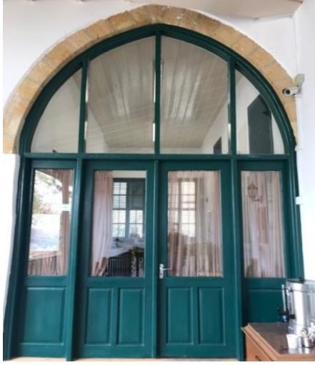
Şekil 4.79: Yunus Emre Enstitüsü Binası eyvan kapısı (Koşanlar, 2018)
