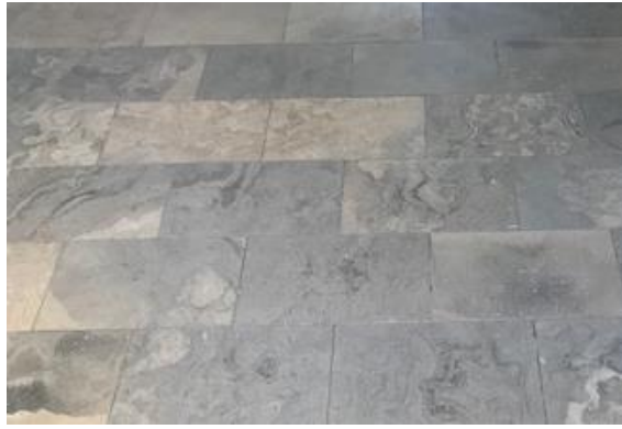
Şekil 4.92: İTÜ Sürekli Eğitim Merkezi Binası alt kat sofa döşemesi (Koşanlar, 2018)
