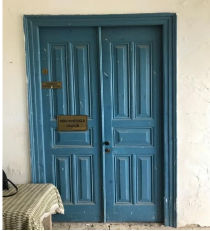
ekil 4.186: Hasder Binası alt kat oda kapısı (Koanlar, 2019)
