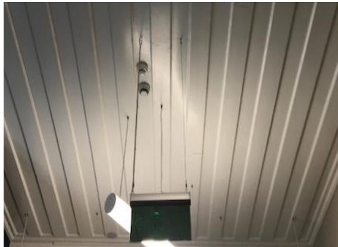
Şekil 4.105: İTÜ Sürekli Eğitim Merkezi Binası üst kat tavanı (Koşanlar, 2018)
