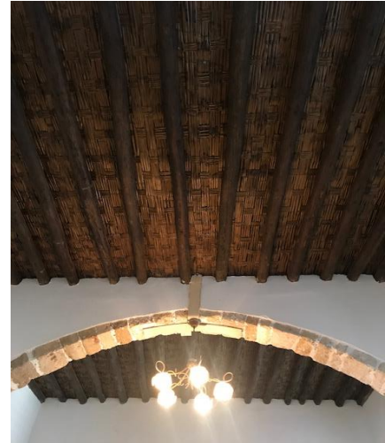
řekil 4.124: Naci Talat Vakfı Binası oda tavanı (Kořanlar, 2018)
