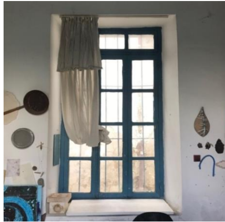
Şekil 4.187: Hasder Binası alt kat oda penceresi (Koşanlar, 2019)
