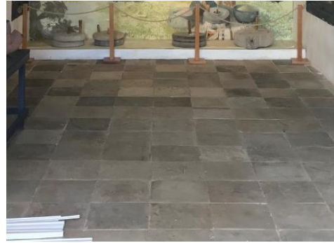
Şekil 4.3: Derviş Paşa Konağı alt kat sofa eyvanı (Koşanlar, 2018)
