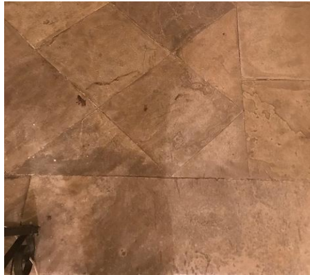
Şekil 4.153: Bohcalian Konağı üst kat sofa döşemesi (Koşanlar, 2018)
