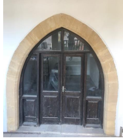
Şekil 4.135: Lüzinyan Evi gotik kemerli camekân (Koşanlar, 2018)
