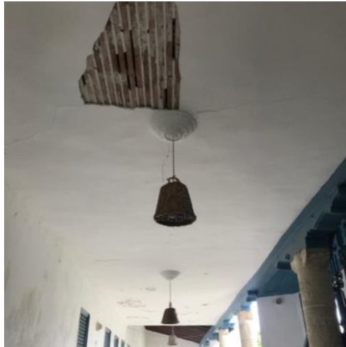
Şekil 4.196: Hasder Binası sofa tavanı (Koşanlar, 2019)
