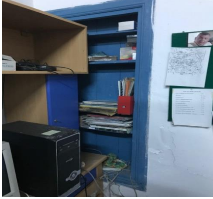
Şekil 4.188: Hasder Binası'nda duvar nişi (Koşanlar, 2019)
