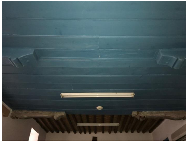
Şekil 4.197: Hasder Binası zemin kat güney-batıdaki oda tavanı (Koşanlar, 2019)
