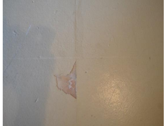
Şekil 4.71: Yunus Emre Enstitüsü Binası alt kat odası (Koşanlar, 2018)
