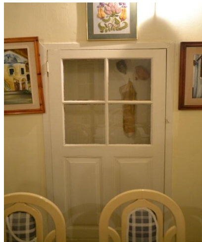
Şekil 4.161: Bohcalian Konağı'nda ahşap camlık kanatlı duvar nişi (Koşanlar, 2018)
