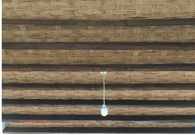
Şekil 4.210: Fransız Kültür Derneği Binası zemin kat sofa tavanı (Koşanlar, 2019)
