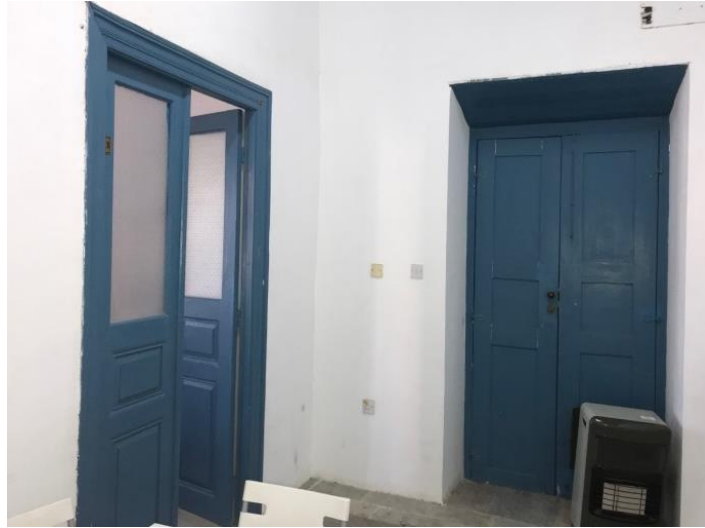
Şekil 4.191: Hasder Binası üst kat oda kapıları (Koşanlar, 2019)
