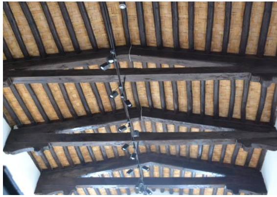
Şekil 4.67: Saçaklı Ev’de makasla taşınan üst kat oda tavanı (Koşanlar, 2018)
