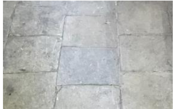
Şekil 4.26: Kadı Menteşoğlu Konağı alt kat oda döşemesi (Koşanlar, 2018)
