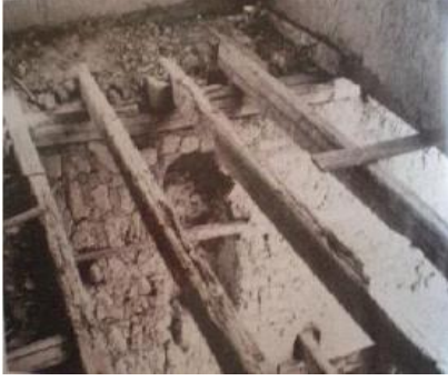
Şekil 3.1: Türk Evi'nde döşemenin yapımı (Küçükerman, 1991)
