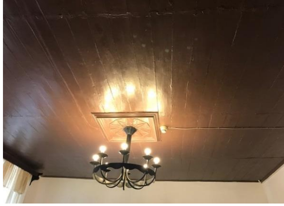
Şekil 4.65: Saçaklı Ev kaplamalı alt kat oda tavanı (Koşanlar, 2018)
