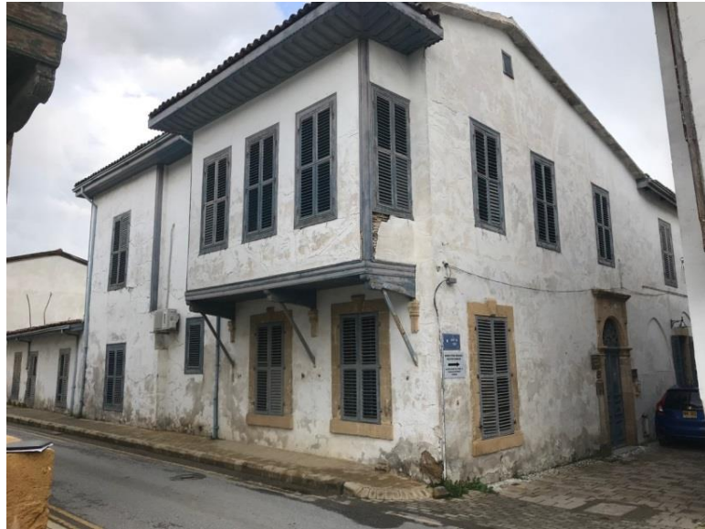
Şekil 4.181: Hasder Binası (Koşanlar, 2019)
