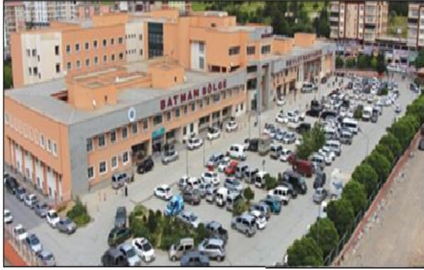
Şekil 4.2: Batman Bölge Devlet Hastanesi dış görünümü
