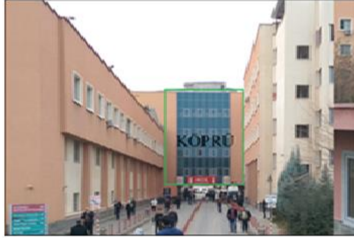
Şekil 4.33: Hastane blokları arasında köprü geçişi
