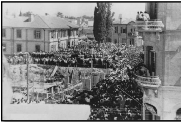
(a) Saray Otel inşaatı-1961 (E. Eryener’den)
