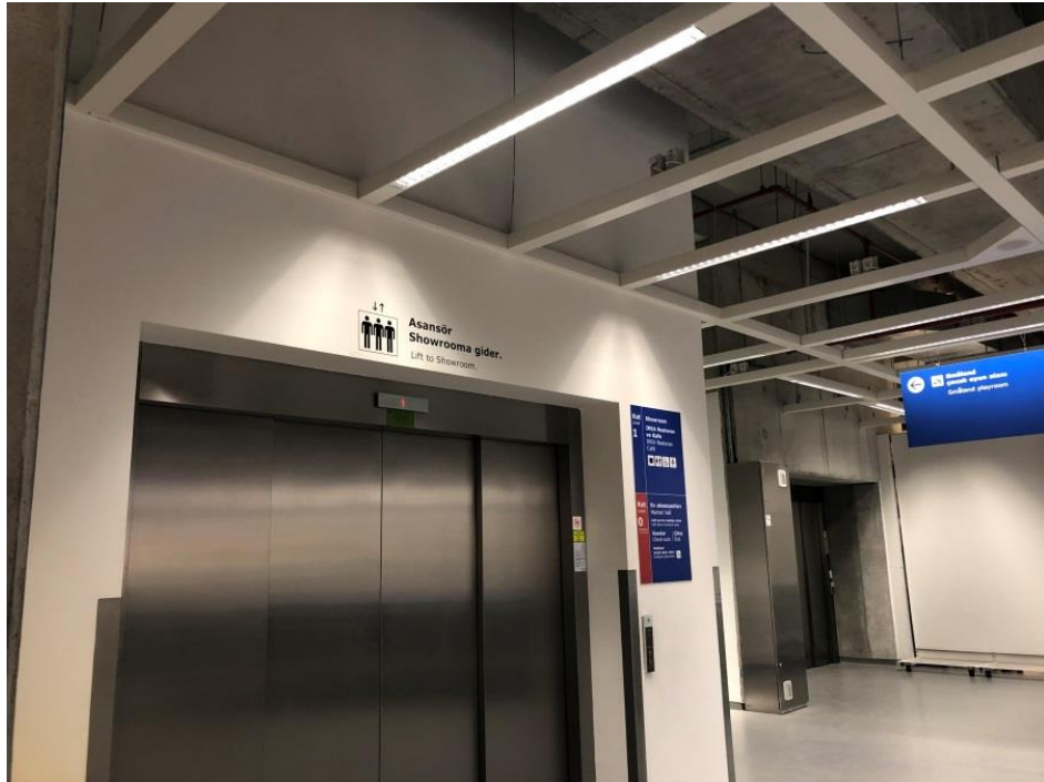
Resim 5.106: İletişim araçlarında TL5 aydınlatma kullanımı
