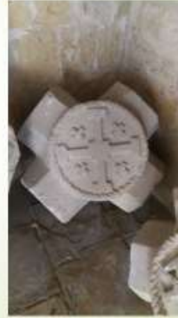
Kilit taşları, sütunların birleşim noktalarında bulunan taşlar. (Sağdaki Kudüs'ün sembolü)
