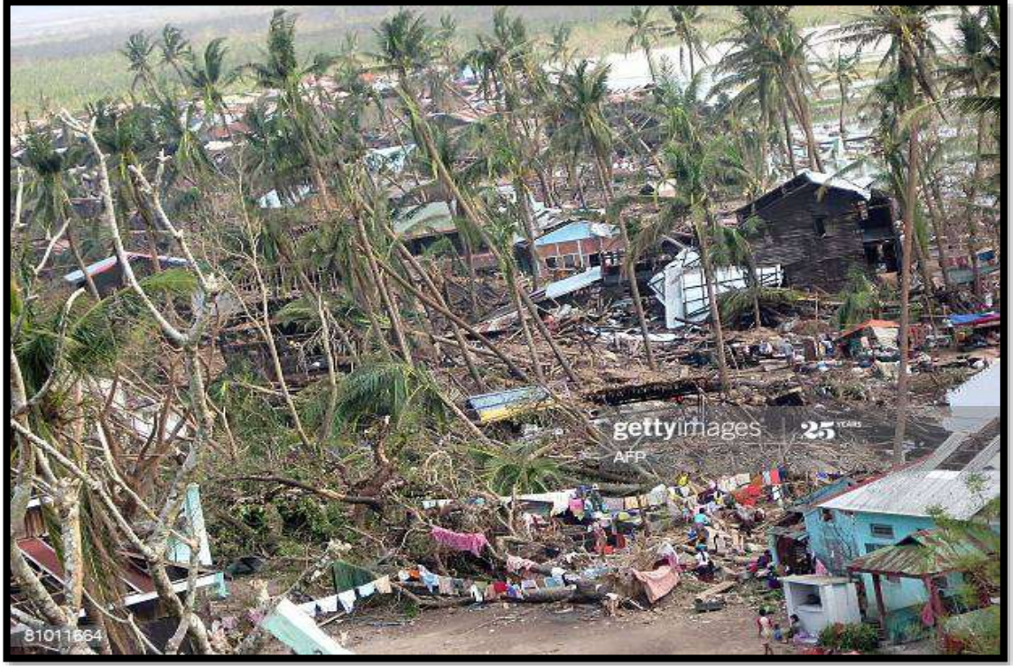
Resim 9 : 2008'de Cyclone Nargis, Myanmar'daki 2.460 okul binasını tahrip etti.
