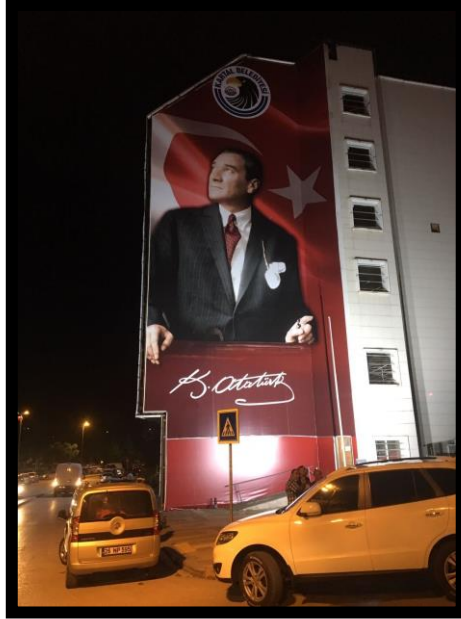
Görüntü 11: Bina Cephesi Reklam Örneği/Kartal Belediyesi
