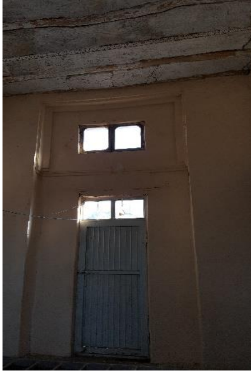
Muhdes Yapının Terasına Çıkan Demir Kapı
