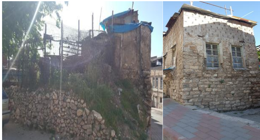
a. Doğu cephesi
