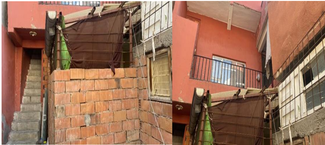
Doğu Cephesindeki Muhdes Birinci Kata Çıkan Merdiven
