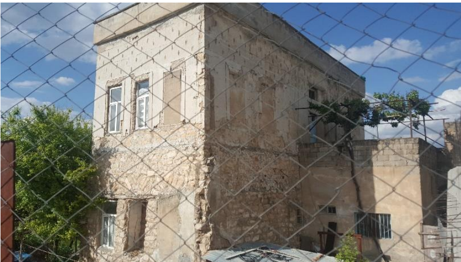
Suat Ertekin Evi Güneybatı Cephesi
