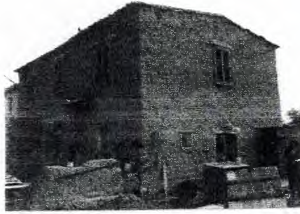
Şekil 31: Gönyeli (P.no.323), dış sofalı tip iki katlı ev'in güney batı görünüşü (Ç.Karaokçu)
