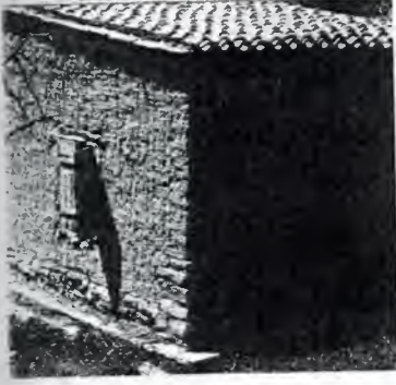
Şekil 7a, b: Subasman ve duvar birleşimi (M. Yakup)
