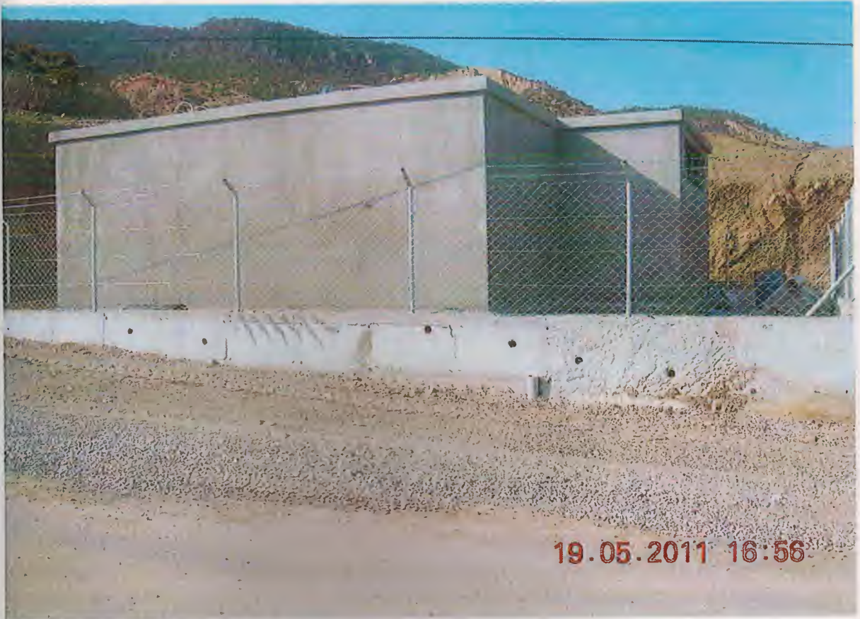
Yapımı devam eden yeni su deposu
