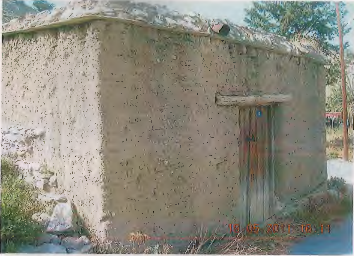
Zamana meydan okuyan kerpiç bina ve tahta kapısı
