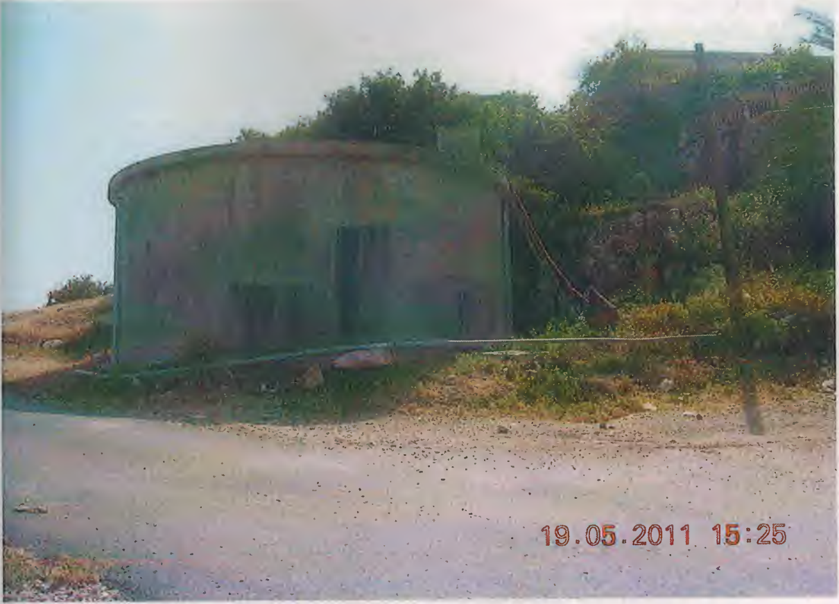
Köyün eski su deposu
