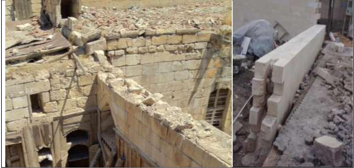
Şekil 4-18: Taş duvar (527 ve 237 Env. No'lu ev) (Kaleoğlu Kanalcı, 2010)
