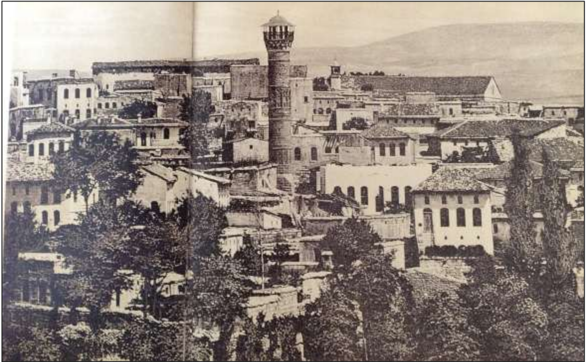
řekil 3-4: Gaziantep geleneksel konut dokusu Türktepe Mahallesi (Bařgelen, 1999).
