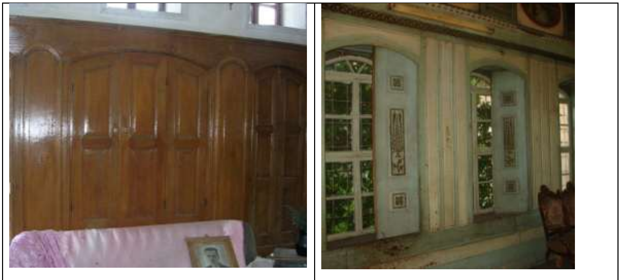
Şekil 4-4: Ahşap nacar duvar ve ahşap pencere (Kaleoğlu Kanalı, 2010)
