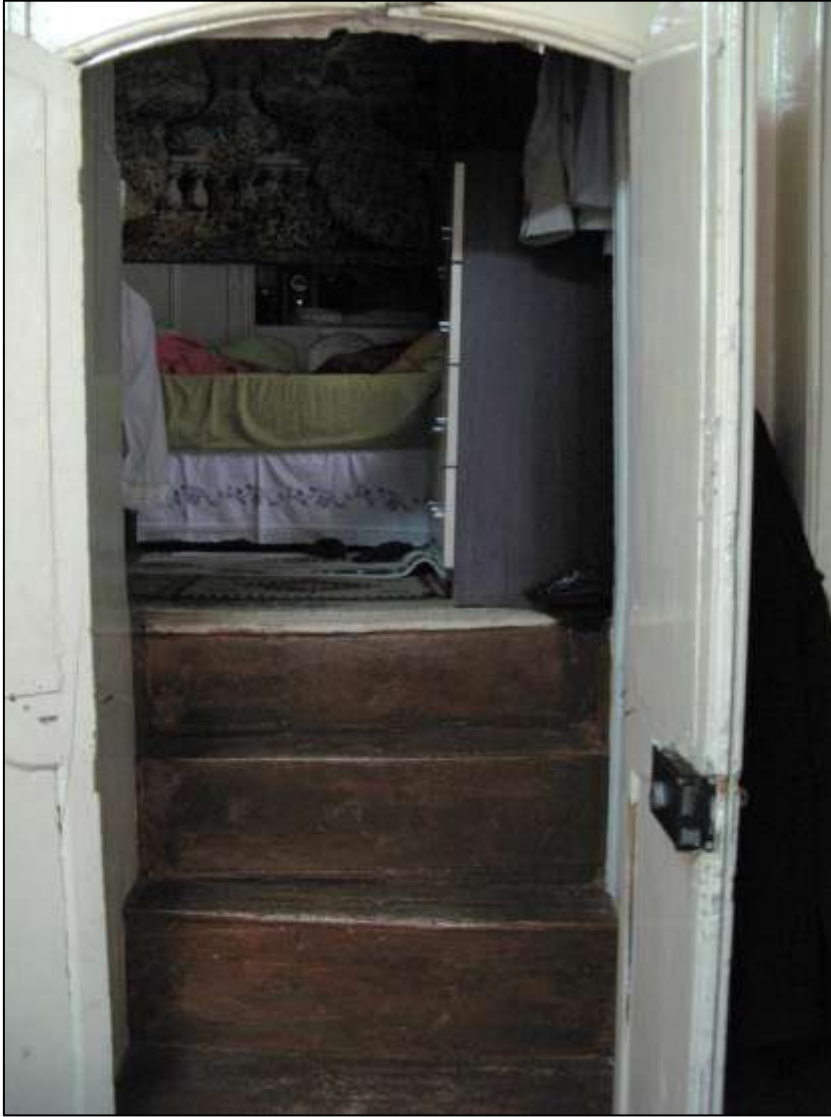
Şekil 4-25: Oda içinden odaya geçiş merdiveni (Kaleoğlu Kanalcı, 2012)
